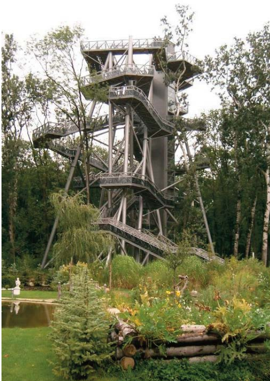
Abb. 32: www.we3.at/index.html?c=&m=8&y=2008&id=293 Der 30 m hohe Baumwipfelweg der GARTEN TULLN besteht aus einem Aussichtsturm mit mehreren Ebenen, Stiegenläufen und Podesten. Die Aussichtsplattform ist auch per Lift erreichbar.
