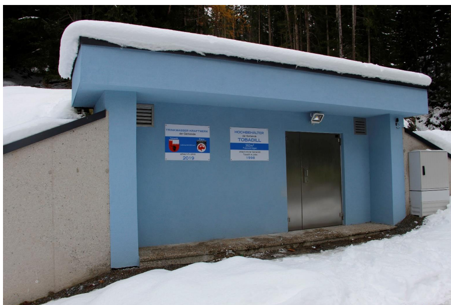
Bild 3: Trinkwasserkraftwerk (Quelle: Gemeinde Tobadill)
