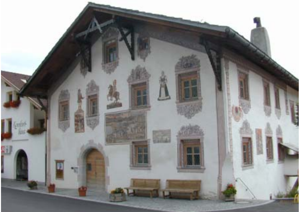
Rechelerhaus (Ladis) nach der Sanierung
