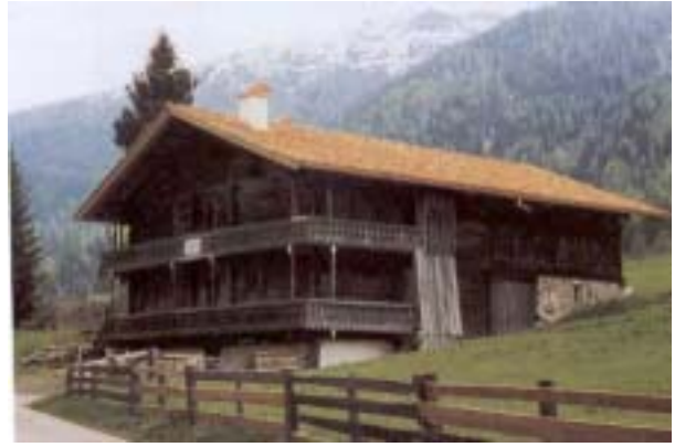
St. Jakob i. D. Feistritz Nr. 13, Zust. 1999
