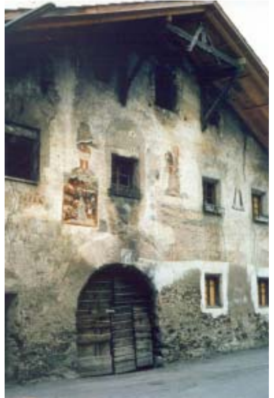
Rechelerhaus vor der Sanierung
