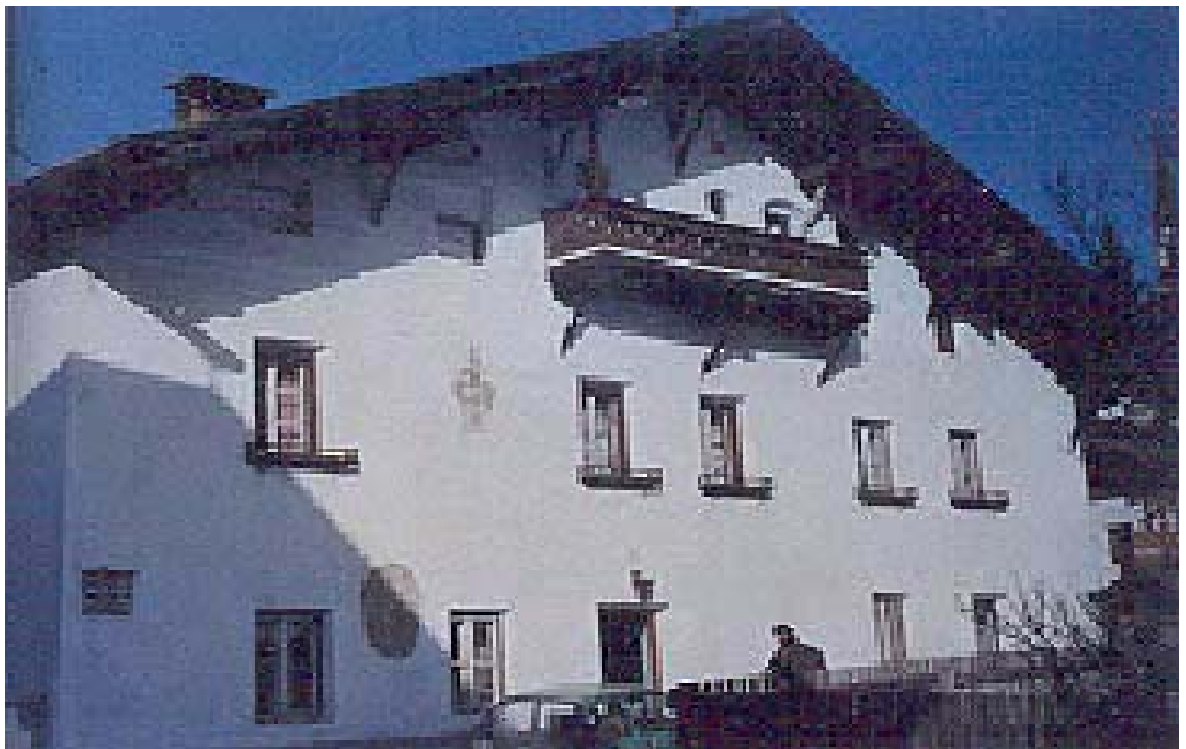
Silz – Objekt vor der Sanierung
