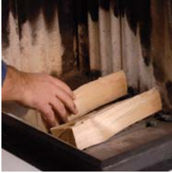
Das Stückholz für eine ausreichende Luftzufuhr locker hineinschichten.
