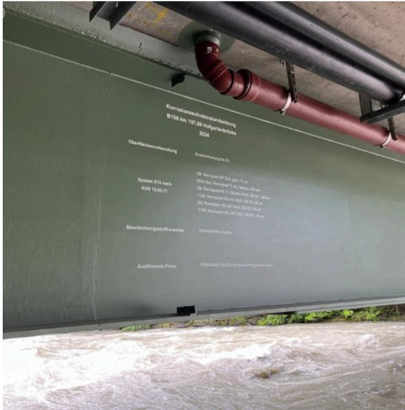
Am Stahltragwerk der Hofgartenbrücke musste auf Grund von Korrosionsschäden die Korrosionsschutzbeschichtung erneuert werden. Gleichzeitig wurde das Tragwerk mittels CFK-Lamellen (Carbonfaserverstärkter Kunststoff) verstärkt.
