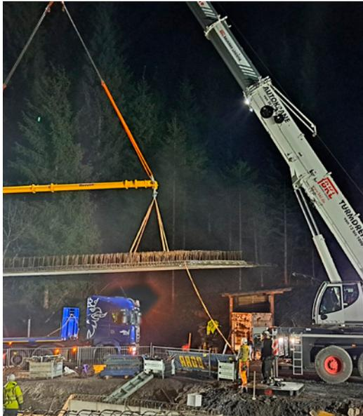
Aufgrund des mäßigen Erhaltungszustandes der bestehenden Brückentragwerke war eine umfassende Instandsetzung erforderlich. Dabei wurden die Tragwerke der drei Brücken abgebrochen, die vorhandenen Widerlager ertüchtigt und anschließend die Tragwerke neu errichtet. Die Verkehrsaufrechterhaltung erfolgte im einspurigen Bereich mittels Ampelregelung über eine Behelfsbrücke bzw. das halbseitige Tragwerk und über eine zweispurige Umfahrungsstraße.
