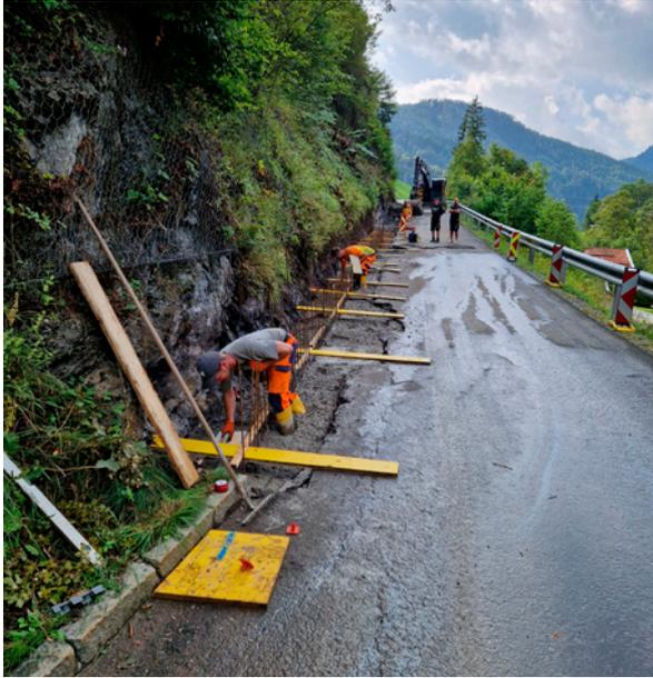
Herstellung eines Sturzraumes hinter der Mauer, da immer wieder kleinere Blöcke von der Böschung bzw. aus der Mauer auf die Fahrbahn gefallen sind.
