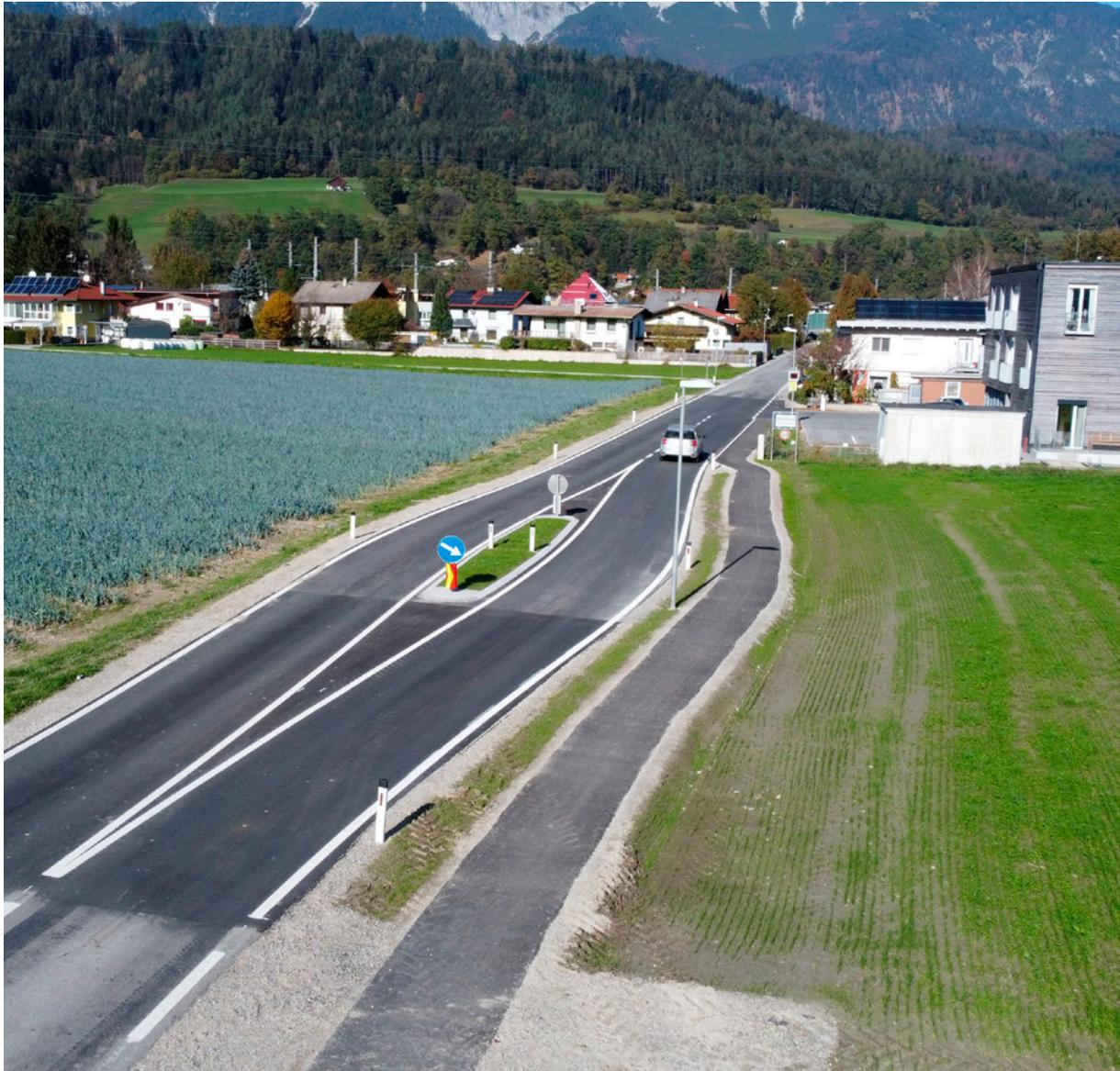
Im Rahmen des Bauvorhabens wurde im Bereich der Ortseinfahrt von Baumkirchen ein von der Fahrbahn getrenntes Gehweg errichtet, um die Sicherheit der Fußgänger zu erhöhen. Zudem wurde im gesamten Baulosbereich die Entwässerung ertüchtigt, wozu auch die Anlage eines Versickerungsbeckens zählt. Ergänzend dazu wurde durch die Gemeinde Baumkirchen eine neue Straßenbeleuchtung entlang des Gehwegs errichtet, um die Verkehrssicherheit weiter zu verbessern.
