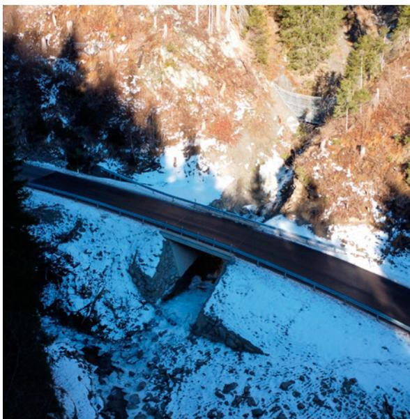
Bei einem Murenabgang im Jahr 2023 wurde das Tragwerk der bestehenden Platschbachbrücke völlig zerstört. Nach der Herstellung eines Provisoriums wurde die Brücke 2024 neu gebaut. Um zukünftige Murenabgänge möglichst schadlos abführen zu können, wurde der Querschnitt des Platschbaches im Bereich der Landesstraße deutlich vergrößert. Zudem wurde oberhalb der Brücke seitens der WLV ein Murenschutznetz errichtet.
