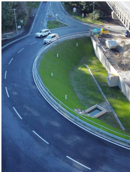
Um das südöstliche Mittelgebirge für Radfahrer an das Stadtgebiet von Innsbruck anzuschließen, wurde, beginnend beim Kreisverkehr Innsbruck Mitte bis zum Schloss Ambras, ein bergwärts führender Radweg geplant. Der erste Bauabschnitt umfasste die Anpassung der Straßenentwässerung und den Bau der ersten 250 m des Radweges. Das Becken in der Mitte des Kreisverkehrs dient dazu, die Straßenwässer zu reinigen und zur endgültigen Versickerung weiterzuleiten.
