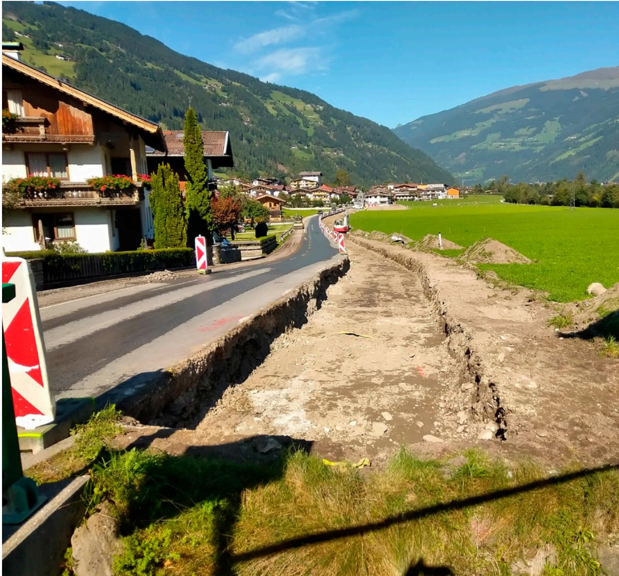
Im dritten Bauabschnitt des Bauvorhabens wurde über die gesamte Bauloslänge ein Gehsteig errichtet, der durch einen erhöhten Randstein gekennzeichnet ist. Diese Maßnahme dient nicht nur der Sicherheit der Fußgänger, sondern schafft auch eine klare Abgrenzung zur Landesstraße. Zusätzlich zur Gehsteigneuerrichtung wurde auch die Oberflächenentwässerung im Bereich der Baumaßnahmen erneuert.
