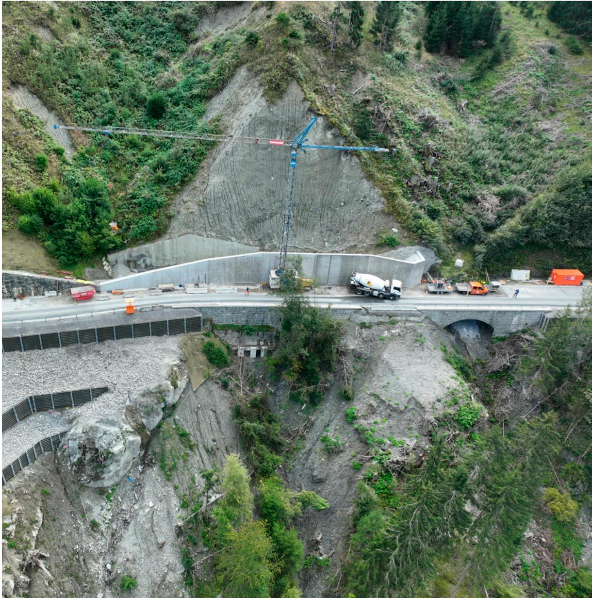
Aufgrund von Starkregenereignissen verbunden mit Tauwetter kam es knapp vor Weihnachten 2023 der L 16 Pitztalstraße zu mehreren größeren Erdbeben. Zur Sicherung der Landesstraße wurden talseitig mehrere Bestandsbauwerke unterfangen und zusätzliche GFK-Ankerwände errichtet. Der bergseitige Hang wurde durch eine 68 m lange Schwerkermauer und eine ca. 3000 m<sup>2</sup> große Hochleistungsnetzwerk sowie eine Mursperre gesichert.
