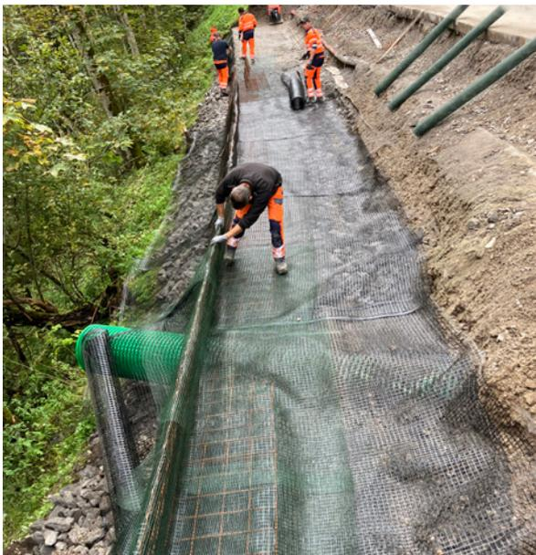
Die Mitarbeiter bringen das Geotextilgitter für die Konstruktion der bewehrten Erde aus.
