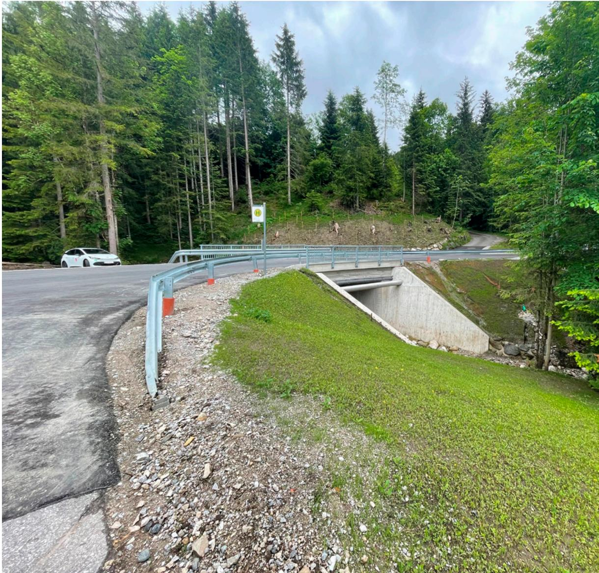
Das Projekt „Ausbau Lärcheneck“ umfasste den Teilneubau der Mühlalbachbrücke sowie die Errichtung einer rückverankerten Vorsatzschale und die Sanierung des Gewölbedurchlasses der Lärcheneckbrücke. Im Frühjahr 2024 wurden die Arbeiten dazu abgeschlossen.
