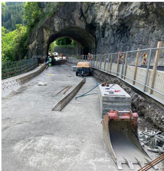
Im Alpbachtal wurde die 1970 errichtete Hangbrücke Lochham II generalsaniert. Die einspurige Verkehrsführung während der Bauzeit wurde der alten Landesstraßenlinienführung nachempfunden. Der Felstunnel, direkt im Anschluss an die Hangbrücke schränkte die Platzverhältnisse für die Sanierung zusätzlich ein. Im Zuge der Sanierung wurde der Abwasserkanal durch die ARAB GmbH abseits des Brückentragwerks neu verlegt.
