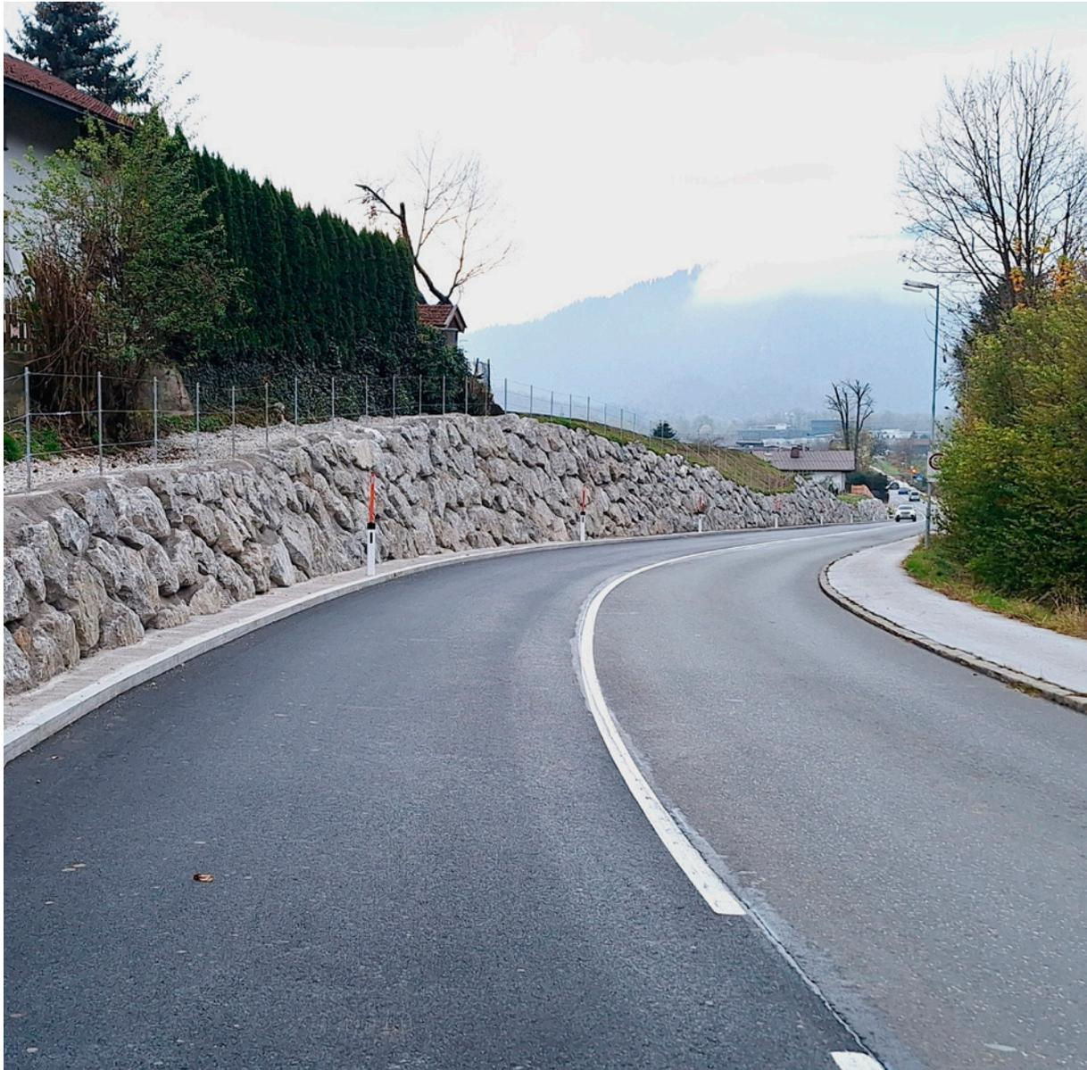
Die bestehende Hangmauer wurde abgebrochen und durch eine in Beton verlegte Steinschichtung ersetzt.
