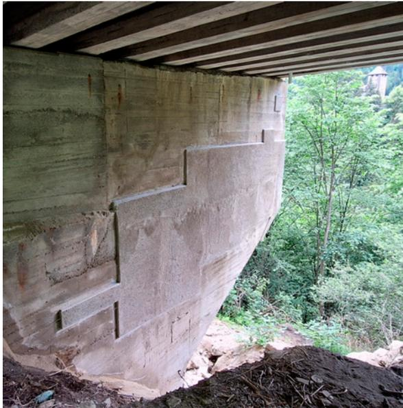
An der Hangbrücke Wiesberg war eine Betoninstandsetzung an den Tragwerksfertigteilen und an den Pfeilerscheiben erforderlich. Ebenso wurde eine Fugensanierung am anschließenden Mauerwerk durchgeführt.
