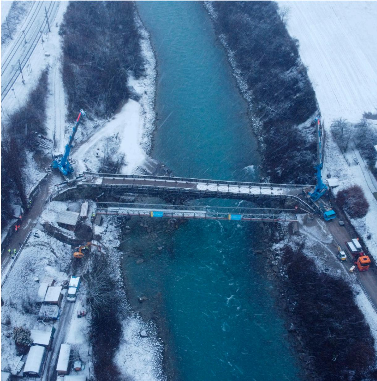
In Amtshilfe für die Gemeinde Roppen konnte 2024 der Neubau der „Roppener Innbrücke“ gestartet werden. Die unter Denkmalschutz stehende Holzbrücke wird aufgrund des Zustandes abgetragen, der Mittelpfeiler entfernt und durch eine – in Anlehnung an die Tragkonstruktion des Bestandes – verkleidete Sprengwerkskonstruktion ohne Pfeiler ersetzt. Sowohl die Planung als auch die Umsetzung erfolgt in enger Abstimmung mit dem Bundesdenkmalamt.
