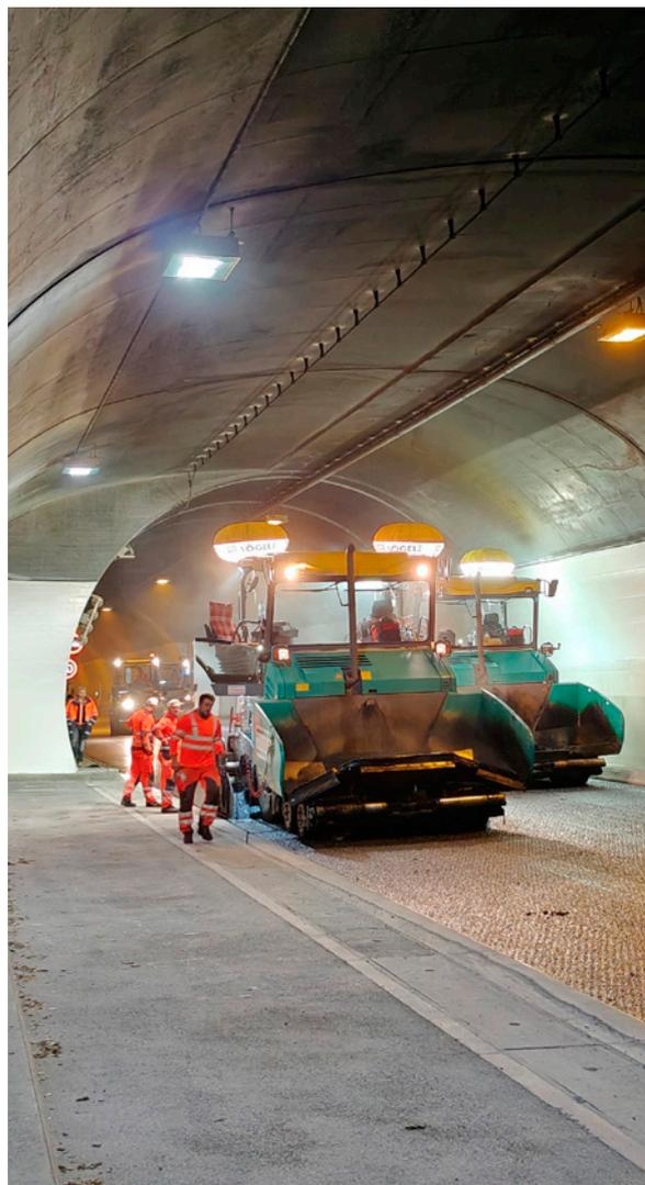
Im Jahr 2024 wurde die erste von drei Bauphasen zur Generalsanierung des Brettfalltunnels mit dem Tunnelanstrich, Erweiterung der Betriebsstation Süd und Neubau im Norden, Fundamenten für die Verkehrstechnik, Haltebuchten in den Vorportalen und Erneuerung des Fahrbahnbelages im Tunnel sowie der Fahrbahnübergänge bei den Brücken im Vorportalbereich Nord abgeschlossen.
