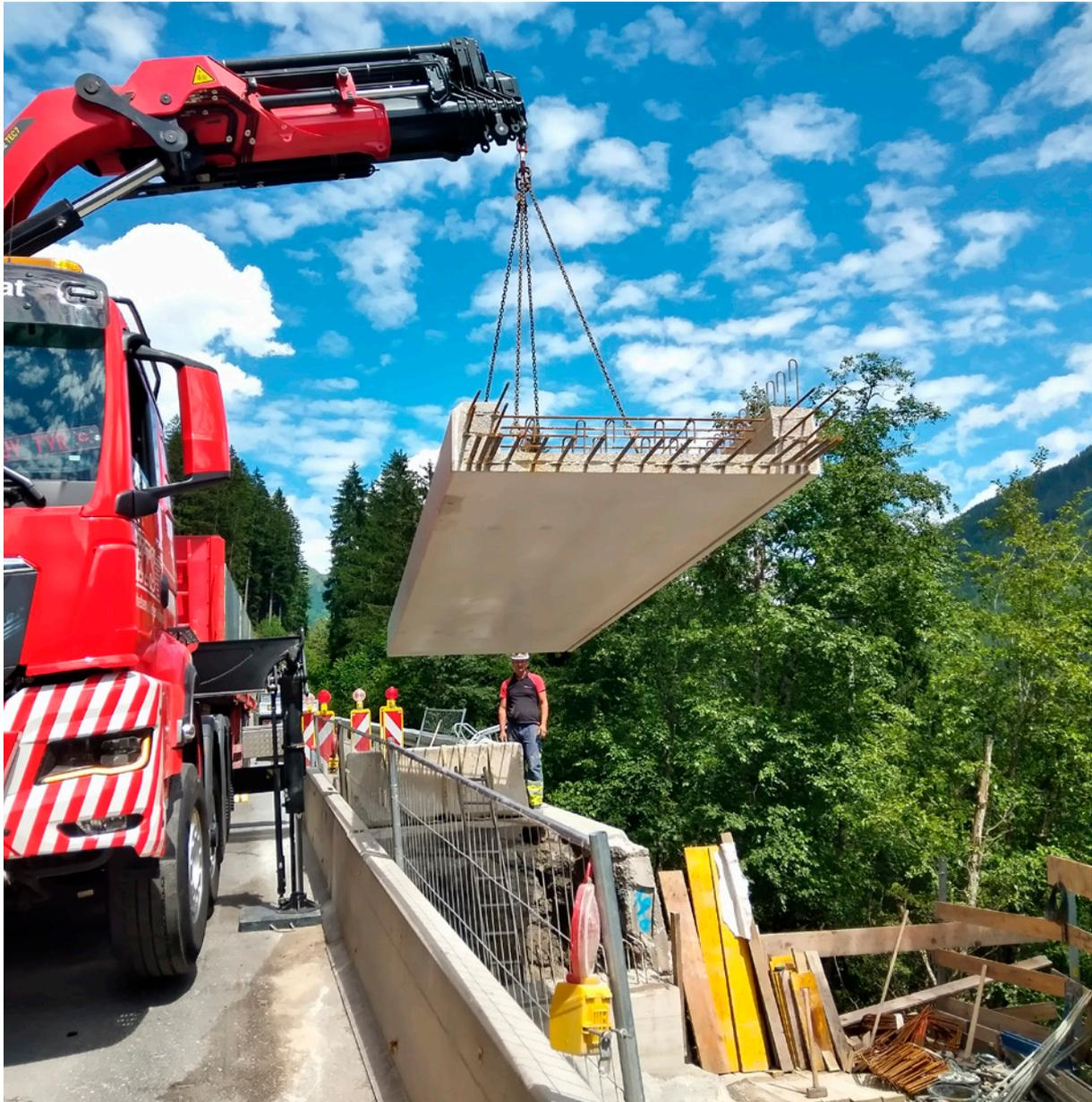
Die im Zuge der Brückenprüfung festgestellten Mängel am Bestand erforderten einen Neubau der Hangbrücke. Aufgrund der beengten Platzverhältnisse war es erforderlich, im ersten Schritt den bergseitigen anstehenden Felsen abzutragen und zu sichern. Um die Beeinträchtigung des Verkehrs möglichst gering zu halten, wurde das Tragwerk als Teil-Fertigteil ausgebildet und so konnte die Bauzeit auf ein Mindestmaß verkürzt werden.
