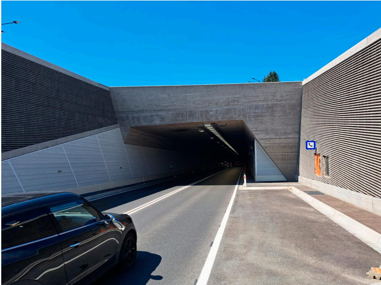
Um die trennende Wirkung in der Gemeinde Scheffau und die Belastungen aus dem Verkehr auf die Anwohner zu reduzieren, wird die B 178 Loferer Straße in einem Teilstück nun als Unterflurtrasse geführt. Der massive Umbau umfasste mehrere Rampen- und Wannenbauwerke sowie das Herzstück, eine rd. 430 m lange Unterflurtrasse. Des Weiteren wurden drei Brücken sowie 500 lfm Lärmschutzwände neu errichtet, die Weißache, der Abwasserkanal, die Gashochdruckleitung und diverse Infrastrukturleitungen umgelegt.
