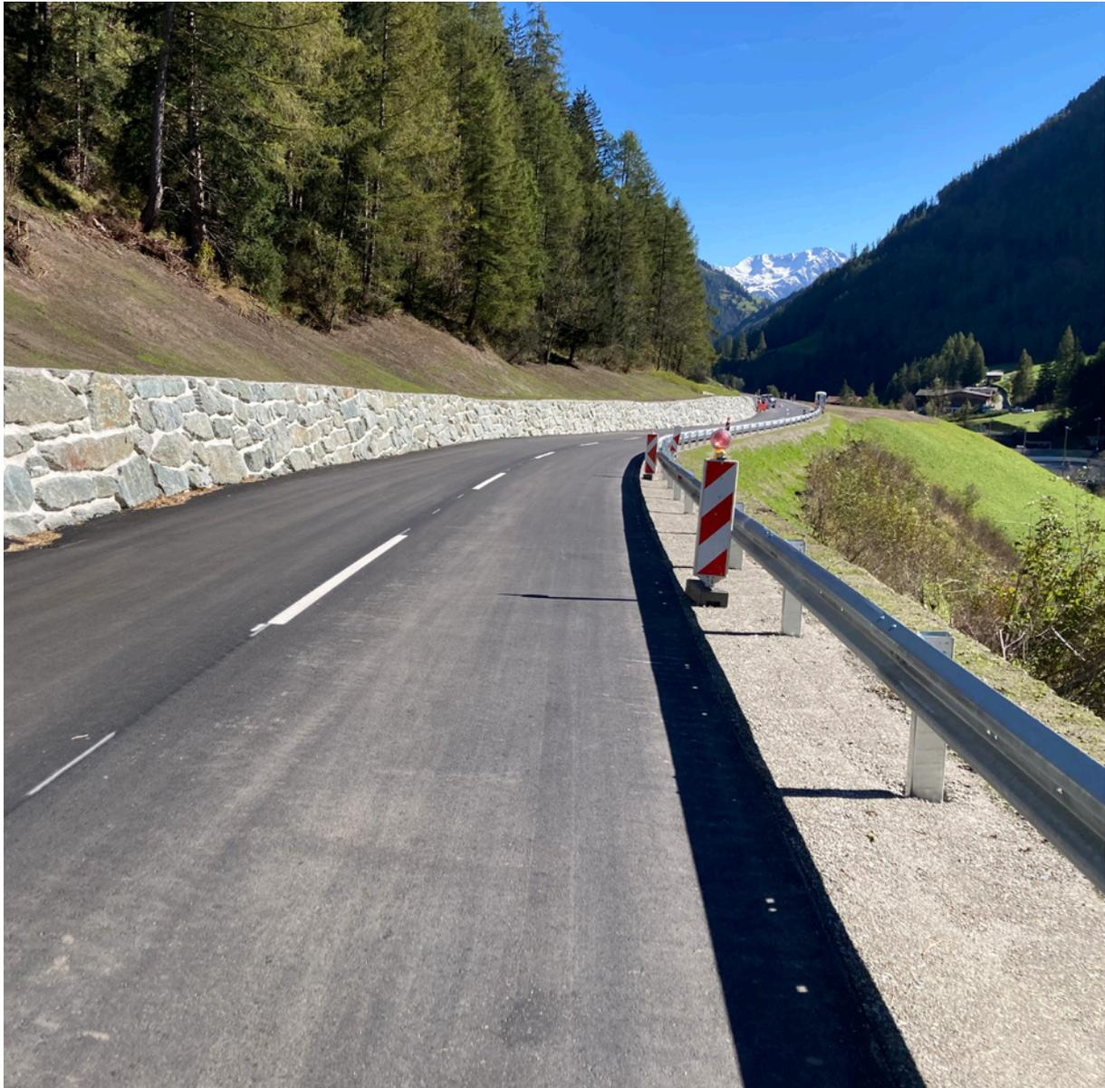
Der nicht mehr dem Stand der Technik entsprechende Abschnitt an der L 24 Virgentalstraße wurde generalsaniert und auf den Regelquerschnitt L 6 ausgebaut. Hierzu wurden der Straßenoberbau und die Asphaltsschichten erneuert sowie die Entwässerung auf den aktuellen Stand der Siedlungswasserwirtschaft gebracht. Die Aufweitungen in den Kurvenbögen wurden für eine Begegnung Bus – Bus ausgelegt, um hier die sichere Begegnung des öffentlichen Verkehrs zu ermöglichen.
