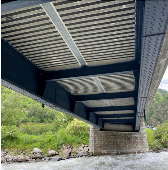
Das Tragwerk der Iselbrücke Huben wurde mittels CFK-Lamellen (Carbonfaserverstärkter Kunststoff) verstärkt. Die Verstärkung war aufgrund eines Sondertransports der Tiwag (Transformator) und den damit einhergehenden Lasten erforderlich.
