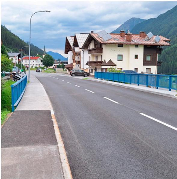
An der Wegunterführung Mathon wurde ein Tragwerksaufbeton hergestellt sowie die Tragwerksabdichtung und der Asphaltaufbau komplett erneuert. Der talseitige desolante Randbalken wurde abgetragene und neu hergestellt. Betoninstandsetzungsarbeiten mussten am Tragwerk durchgeführt werden.
