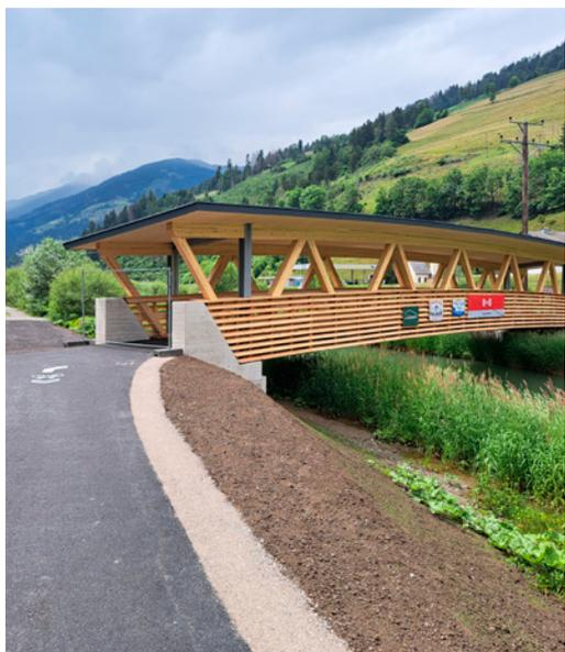
Um die Querung der Drau für die Radfahrer im Bereich der B 111 Gailtalstraße sicherer zu gestalten, wurde in Tassenbach, einem Ortsteil der Gemeinde Strassen, parallel zur bestehenden Draubrücke eine Geh- und Radwegbrücke errichtet. Bei der Brücke handelt es sich um eine einfeldrige Fachwerksbrücke aus Holz und Stahl. Die beiden Widerlager wurden in Beton hergestellt und sind auf duktilen Ramm-pfählen gegründet. Dies war aufgrund der örtlichen Gegebenheiten des Untergrundes erforderlich.
