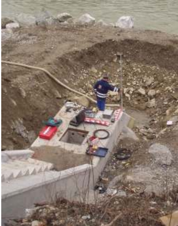
Hinter dem Fangedamm wird die Pegelstiege im Trockenem errichtet.
