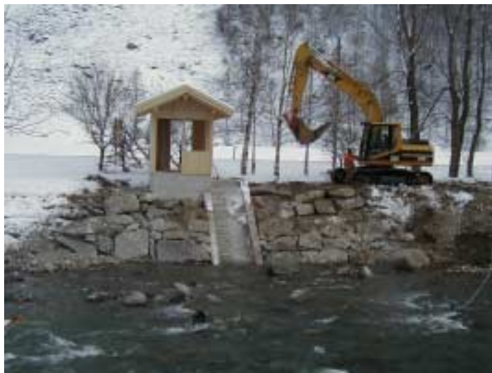
Fertigstellung Deckwerk
