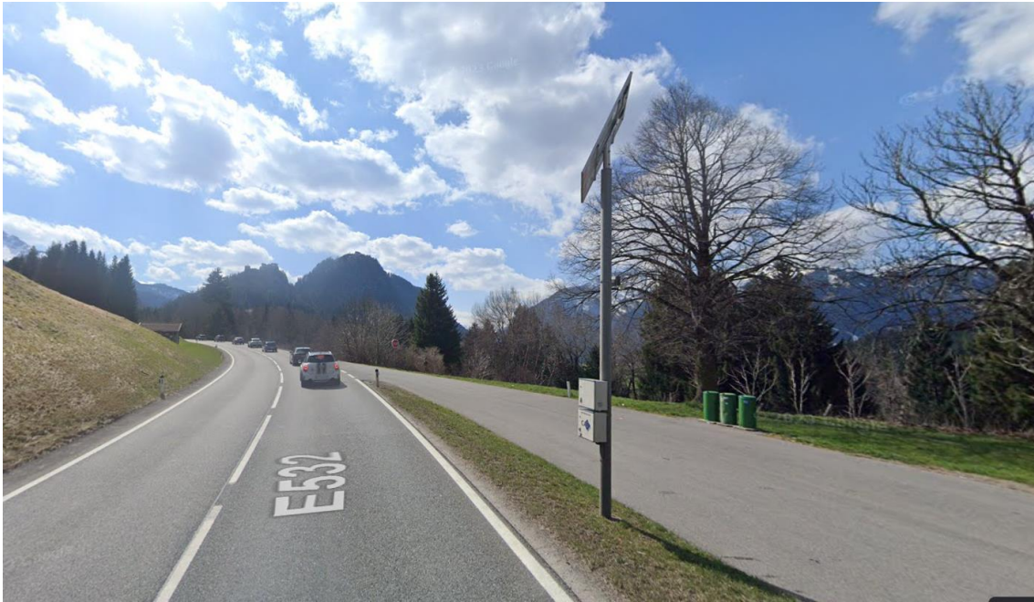
Abbildung 2-2: Zähleinrichtung zur Steuerung der Dosierrampe auf der B179 bei km 35,3
