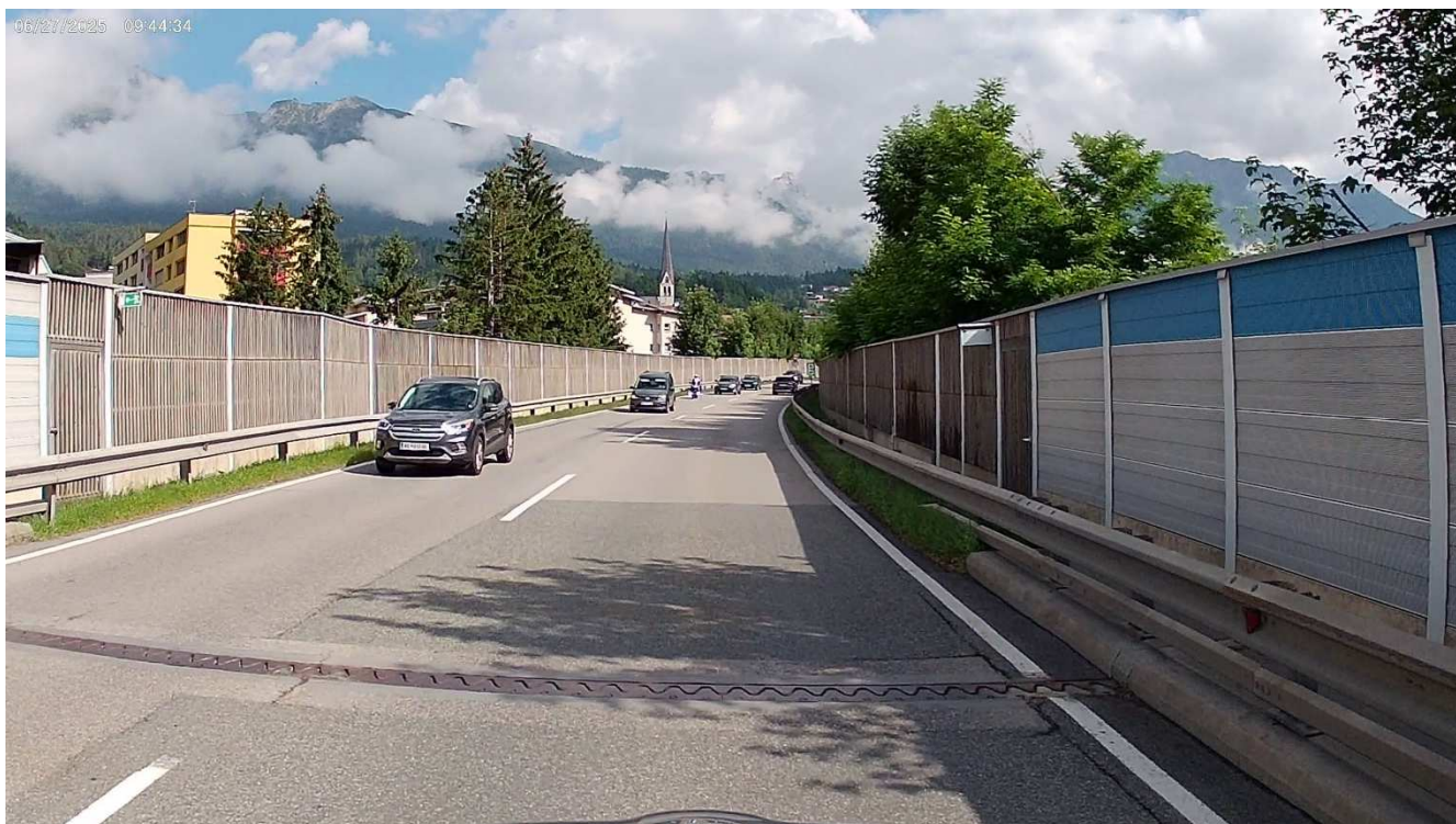
Bild 13 Blickrichtung Nord, Standpunkt auf Brücke bei km 35,20 /4/
