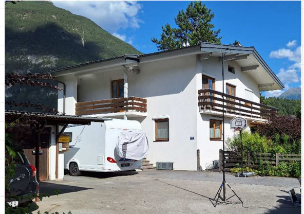
Blickrichtung Südost, nördl. und westl. Hausfassade /4/
