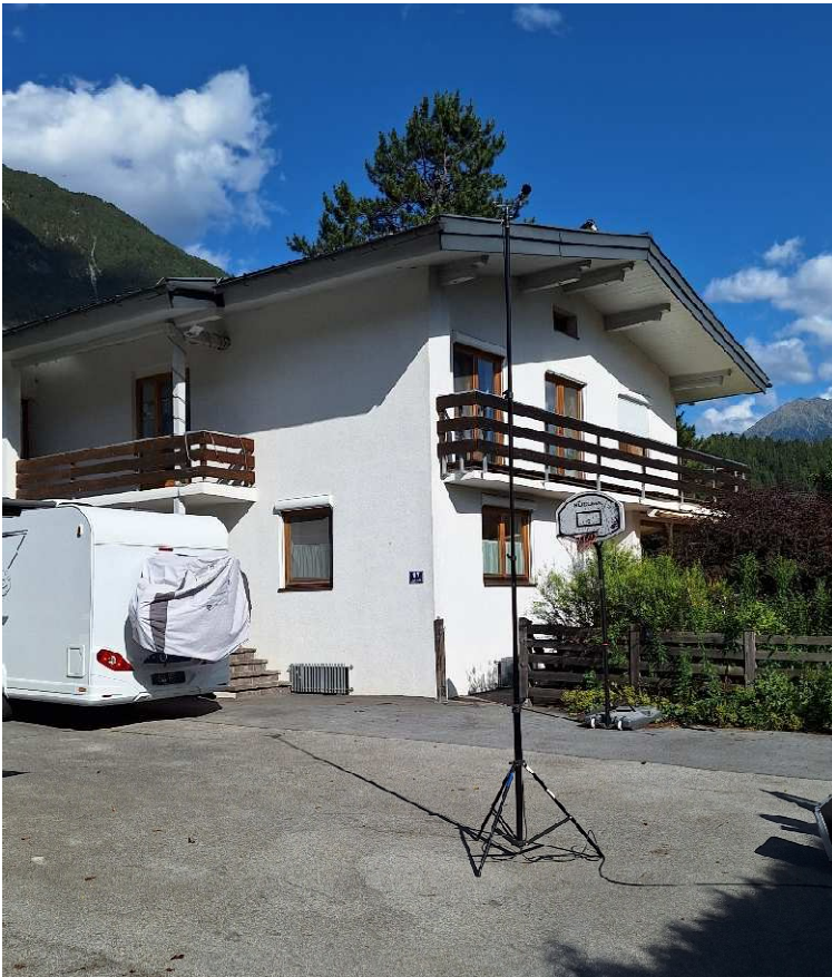
Bild 24 Bereich MP1, Blickrichtung Südost, Gebäude Auf Arzill Nr. 17 /4/
