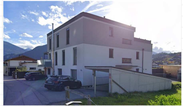
Blickrichtung Südwest, nördl. und östl. Hausfassade /8
