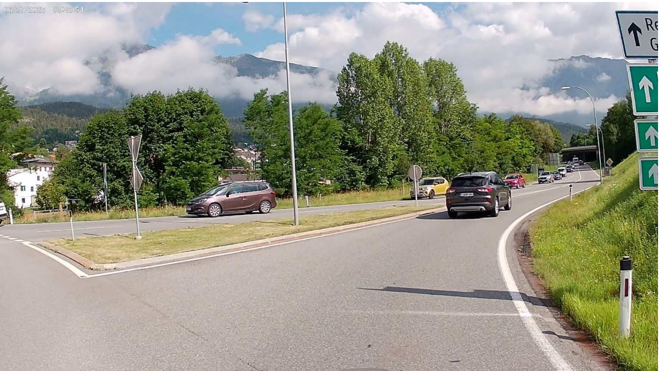
Bild 6 Ausfahrt Kreisverkehr, Fahrtrichtung Nord, Standpunkt bei km 35,765 /4/
