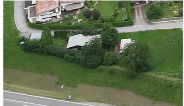
Blickrichtung Südwest, nördl. und östl. Hausfassade /4/
