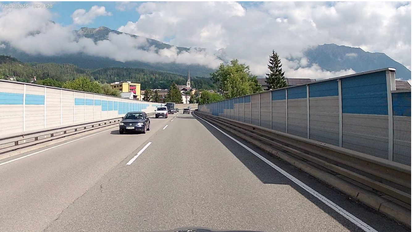
Bild 12 Blickrichtung Nord, Standpunkt auf Brücke bei km 35,33 /4/
