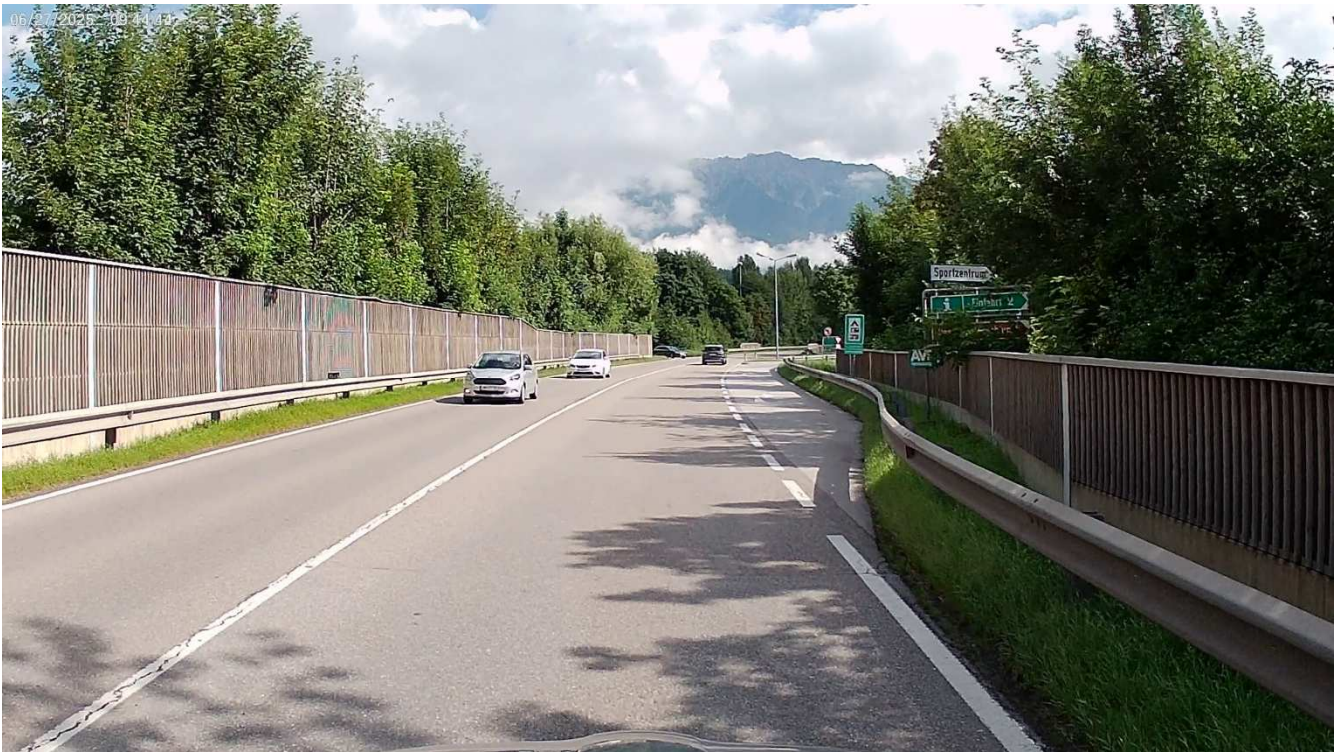
Bild 15 Blickrichtung Nordost, Standpunkt bei km 35,02 /4/
