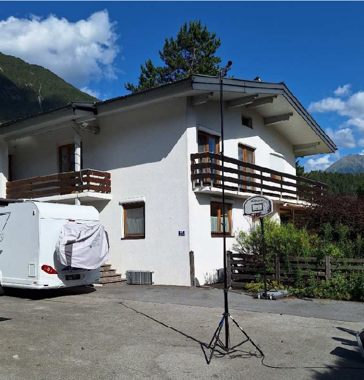
Bild 17 Blickrichtung Südost, Gebäude Auf Arzill Nr. 17 mit Messpunkt MP 1 /4/ Lage des Messpunktes MP1 (Hauptmesspunkt)
