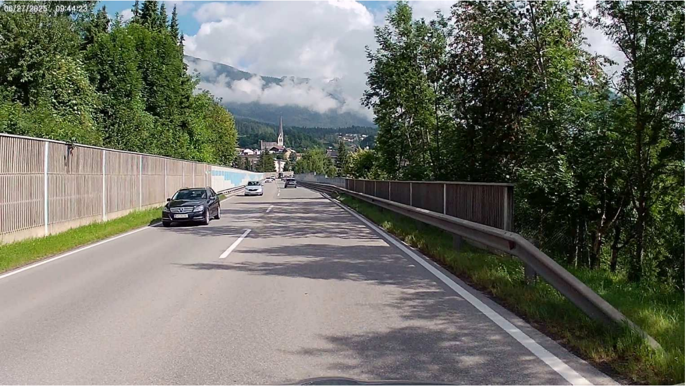
Bild 11 Blickrichtung Nord, LSW Bestand auf beiden Straßenseiten, Standpunkt bei km 35,38 /4/
