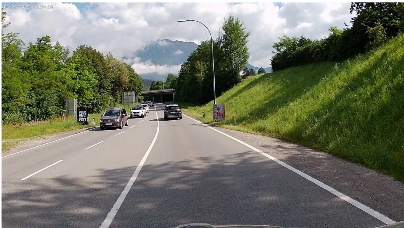
Bild 7 Blickrichtung Nord, Standpunkt bei km 35,72 (direkt bei Steher rechts) /4/
