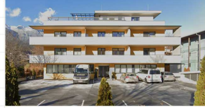
Blickrichtung Nord, südl. Hausfassade /8/
