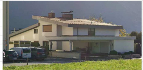
Blickrichtung Südwest, nördl. und östl. Hausfassade /8
