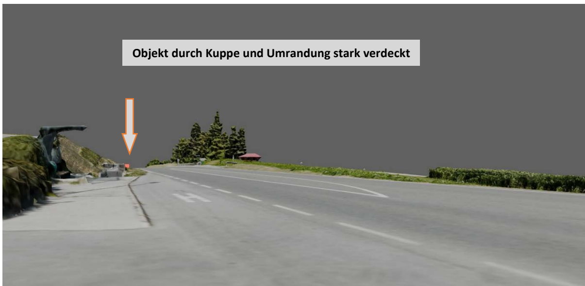
Abbildung 3-4: Sichtweite a_{\min} 155\text{m} ( V_{\text{zul}} = 80 \text{ km/h} )
