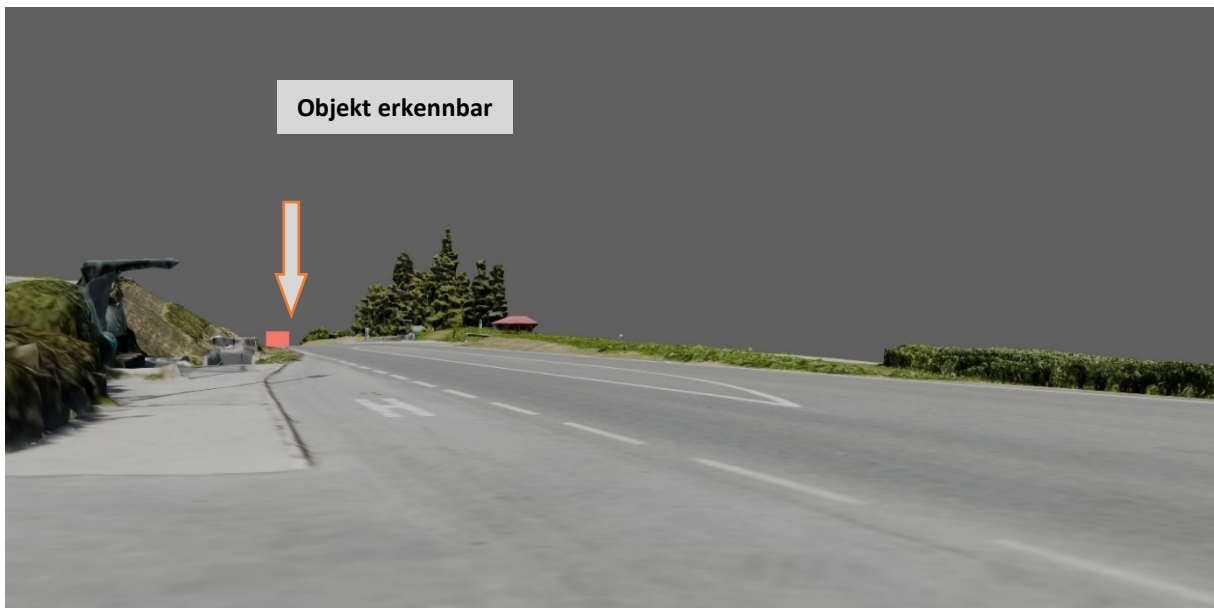
Abbildung 3-6: Sichtweite a 110m ( V_{zul} = 60 km/h)
