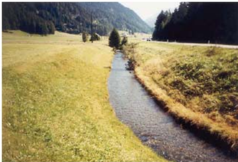
Typ reguliert : reguliertes Ufer, ohne sichtbare Böschungssicherungen (Stiller Bach)
