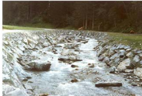
Typ Steinschichtung : Glatt verlegte, nicht verfugte Steinschichtung (Navisbach)
