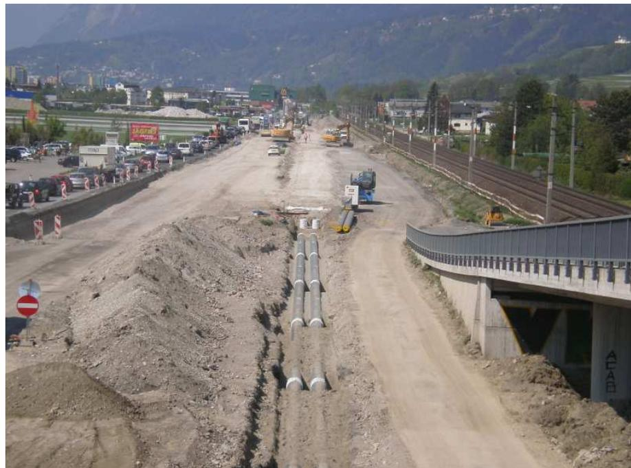
Bild 3: Straßenunterbau und Fernwärmeleitung TIGAS
