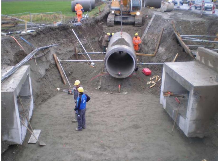
Bild 5: Hochwasserentlastungskanal und Einleitungsbauwerk
