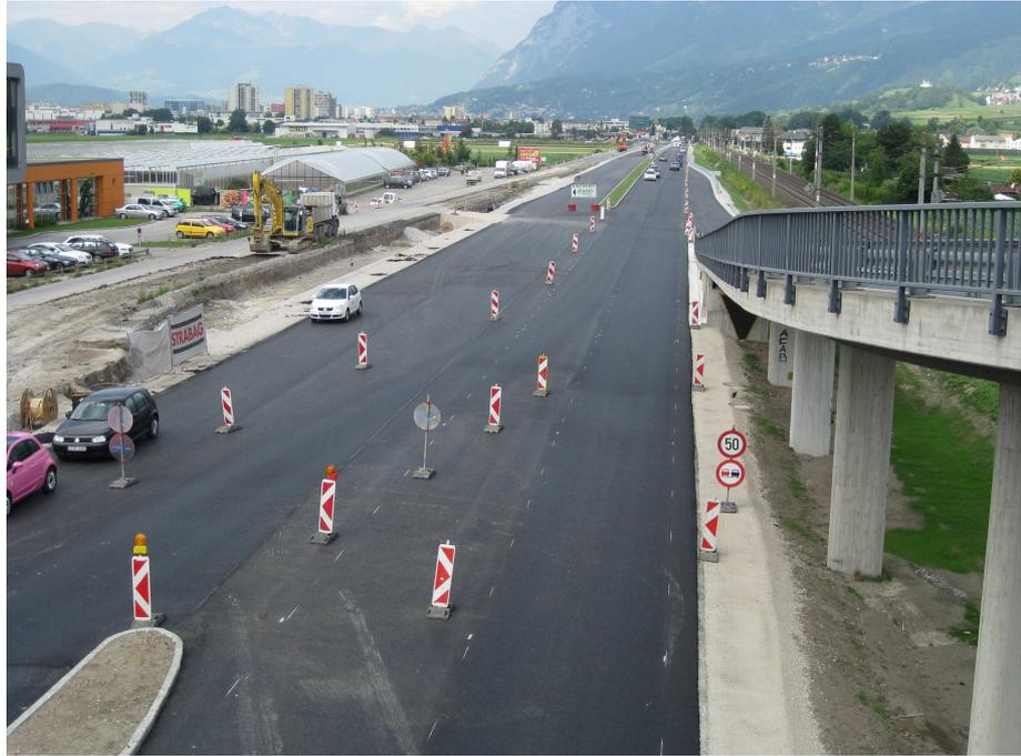
Bild 6: Provisorische Verkehrsführung auf der B 171
