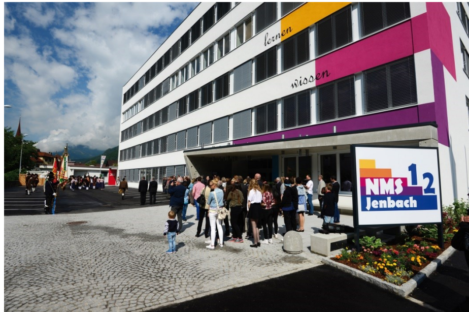
Bild 2: Neue Mittelschule Jenbach I und II
