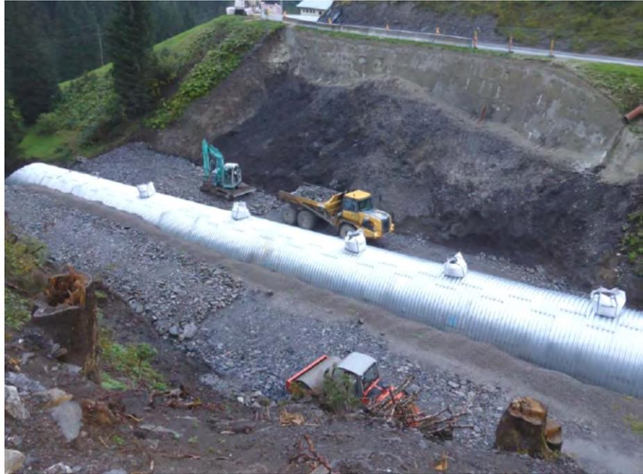
Bild 6: Wellblechdurchlass des Lechleitenbaches und Beginn der Dammschüttung, 10.9.2014 (Foto: Baustellenkoordination)
