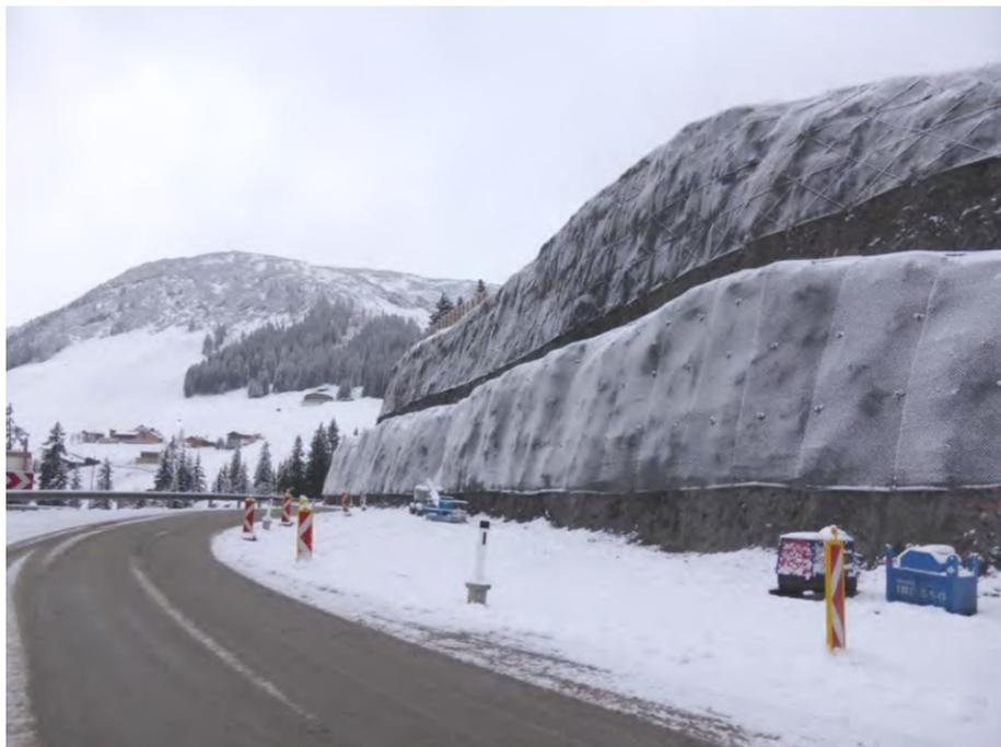
Bild 7: Baustellensicherung für die Winterpause im Bereich des Felsabtrags, 19.11.2014 (Foto: Baustellenkoordination)
