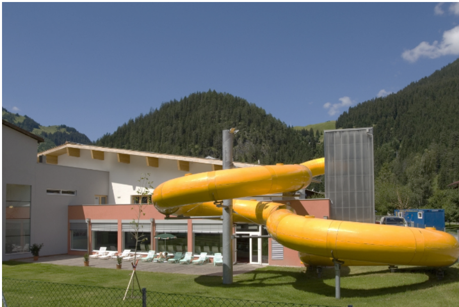
Bild 7: Aqua Nova Steeg – Außenansicht (Quelle: Gemeinde Steeg)
