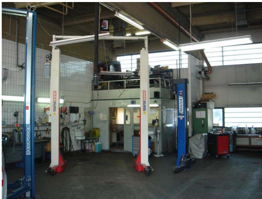
Bild 5: Betriebswerkstätte (Quelle: Land Tirol)
