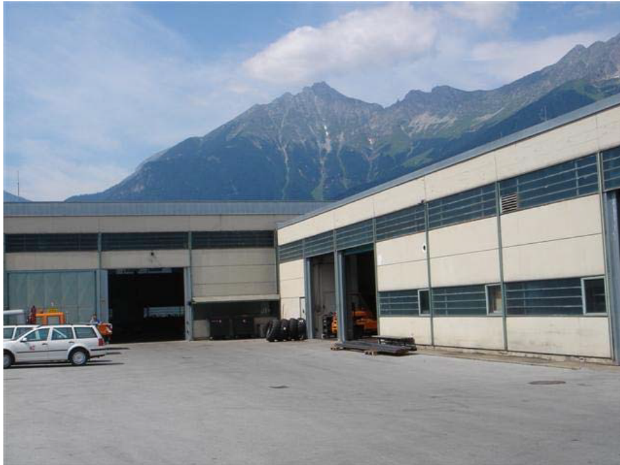
Bild 3: Betriebswerkstätte des Sachgebietes Fahrzeug- und Maschinenlogistik in Innsbruck (Quelle: Land Tirol)
