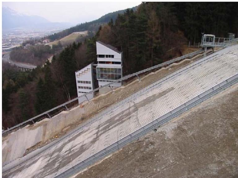
**Schrägaufzug** An der Ostseite des Stadions wurde unmittelbar nach dem Eingangsgebäude ein Schrägaufzug für den Personentransport errichtet. Dieser führt über eine Mittelstation auf Höhe des Schanzenvorbaus zum Erdgeschoß des Sprungturmes.
