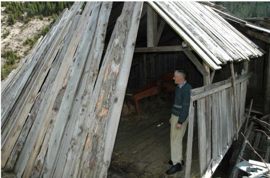
**Bild 6 Für übliche Berg-Landmaschinen ungeeignete Tenneneinfahrt (Statisch und Durchfahrtsquerschnitt, bzw. -höhe)**
