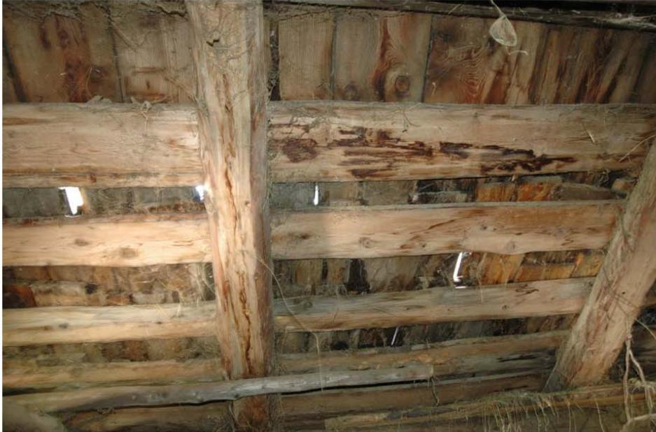
**Bild 5 Undichtes Dach im Wirtschaftstrakt der Hofstelle „Innerreiter“**
