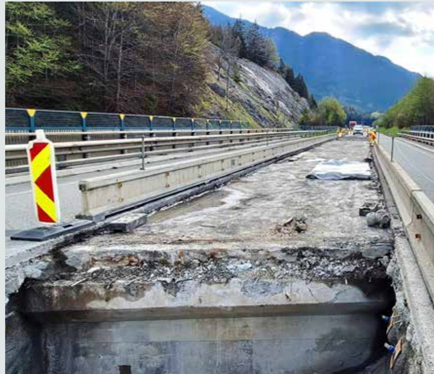
Erhaltungsmaßnahmen, wie hier an der Unterführung Pinswanger Straße, werden in bewährter Form von den zuständigen Fachabteilungen und den Baubezirksämtern im Auftrag der Fernpassstraße GmbH durchgeführt.
