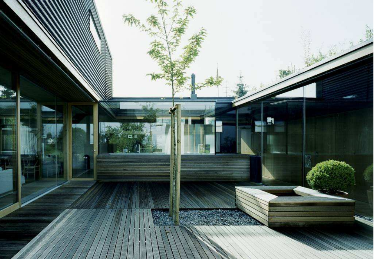
Abb. 5, Arch. Köberl / Pointecker: Haus H., Rorschachberg (CH), Photo: Lukas Schaller ( www.lukasschaller.at ), mit freundlicher Genehmigung von Architekt Köberl ( http://www.rainerkoeberl.at ): Das geräumige Atrium bildet einen windgeschützten intimen Freibereich für die Bewohner; kein Abstandsgrün, sondern wirkliche Erweiterung des Wohnraumes unter freiem Himmel.
