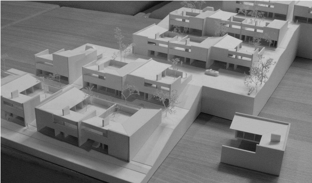
Abb. 1: Arch. Martin Scharfetter, Gartenhofsiedlung Birchfeld in Mutters: Das Demonstrationsmodell zeigt L - förmige Baukörper, die durch verschiedene Orientierungen zu kleinen oder größeren Atrien (Höfen) zusammengefügt werden. Durch die Hanglage entsteht außerdem ein Eingangsgeschoß, in dem Lagerräume und Stellplätze untergebracht werden können.
