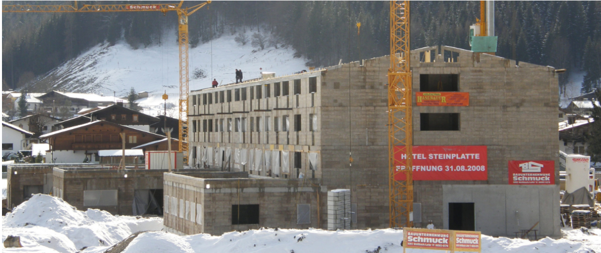
Beherbergungsgroßbetrieb im Bau Photo: Schönherr Martin
