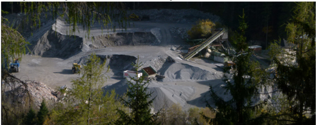
Eine Aufbereitungsanlage für mineralische Rohstoffe. Photo: Schönherr Martin
