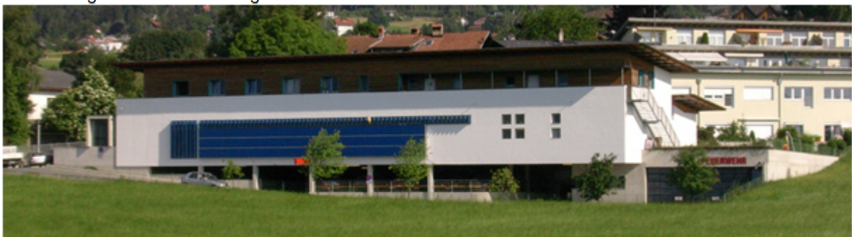
Zwar in Ortsrandlage aber dafür mit Nutzungsüberlagerung wurden hier Lebensmittelmarkt, Feuerwehr, Wohnungen in einem Gebäude realisiert. Photo: Schönherr Martin
