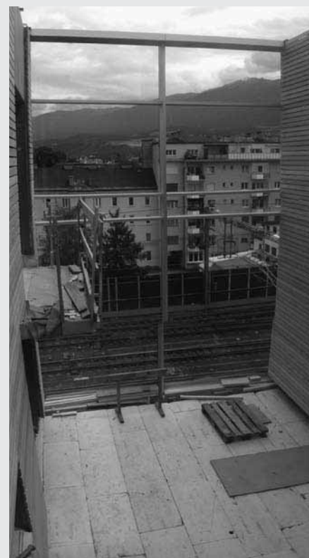
Blick vom Halbatrium durch die Lärmschutzverglasung auf die Bahnstrecke
