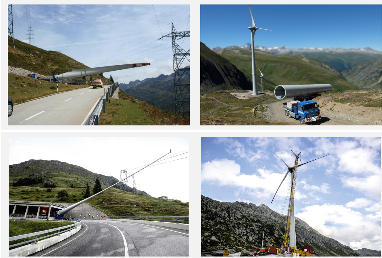
Abb. 6: Beispiele für Transport und Aufstellung von Windkraftanlagen im Hochgebirge
