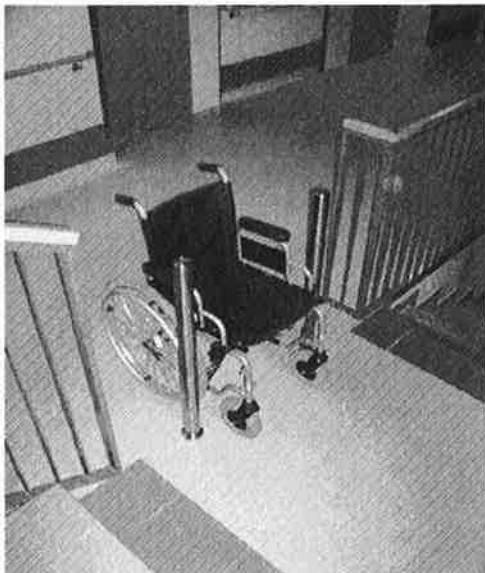
Abbildung 1: Poller als Absturzsicherung. Quelle: Technische Grundlagen für die Beurteilung von Pflegeheimen des Bundeslandes Steiermark
