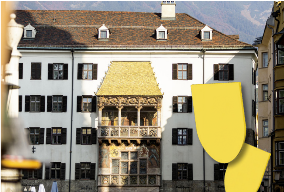
Kriminalfall „Goldenes Dachl“ – acht Schindeln wurden gestohlen.
