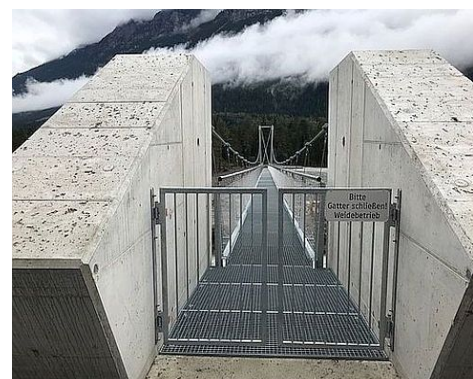
Abbildung 6: Hängebrücke in Forchach
