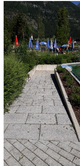
Abbildung 4: Rampe zum barrierefreien Einstieg im Badino in Vorderhornbach
