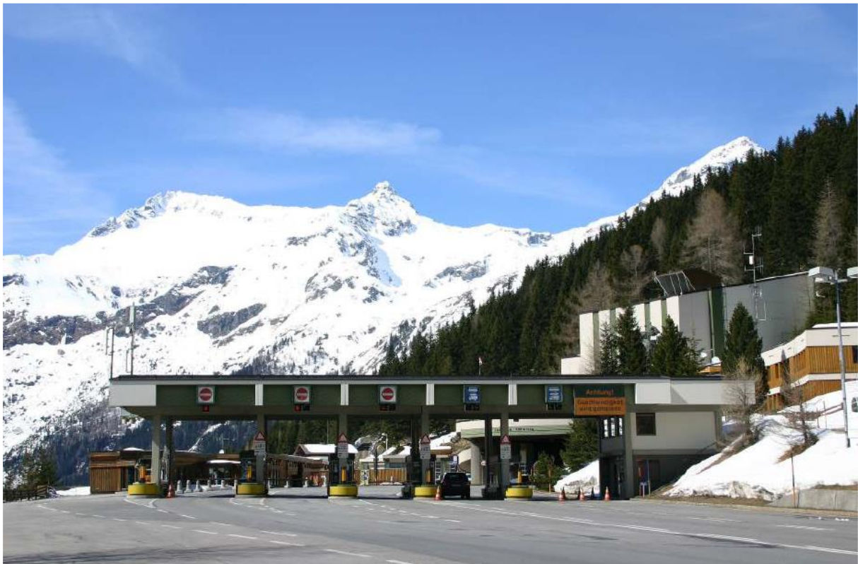
Bild 4: Portal des Felber-Tauern-Tunnels auf Osttiroler Seite
