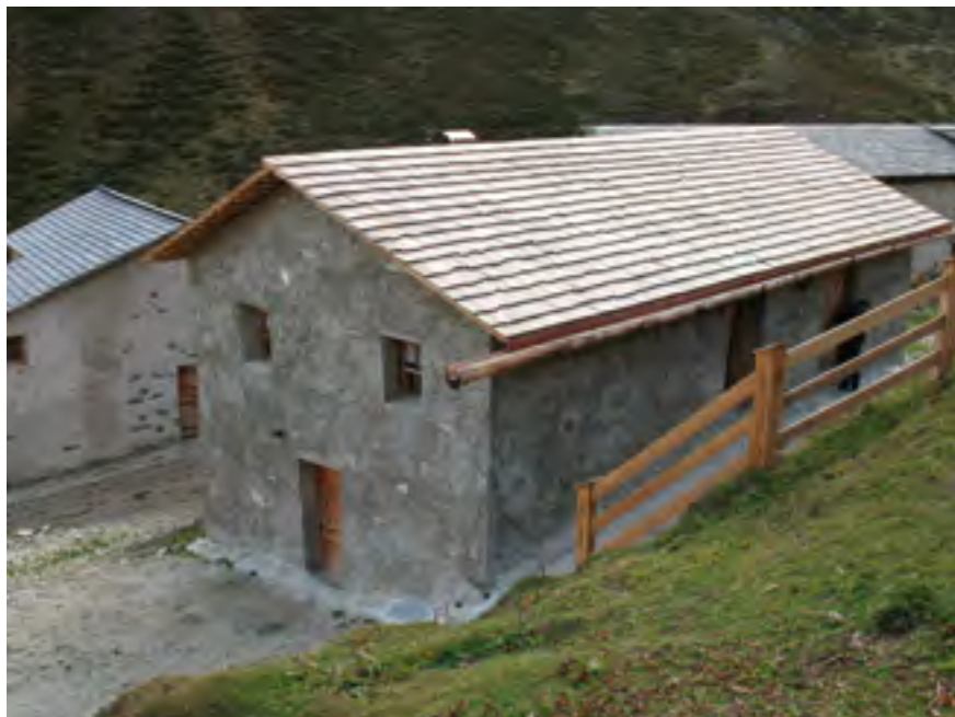
St. Jakob i. D., Jagdhausalm, Haus 3, Almgebäude nach Sanierung, 2009 Foto: Rampold
