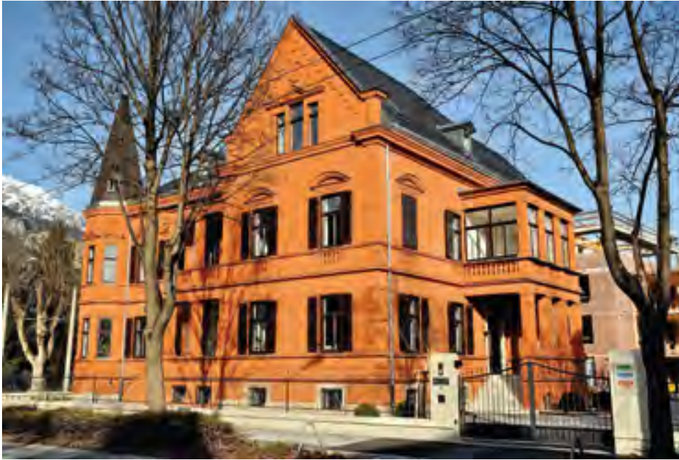
Innsbruck, Kaiserjägerstrasse 24, Ansicht von Südwesten, 2010 | Foto: Jud
