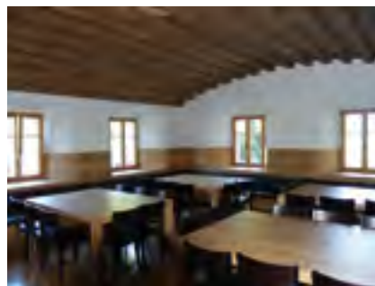
Stube mit gewölbter gotischer Holzbalkendecke, 2009
