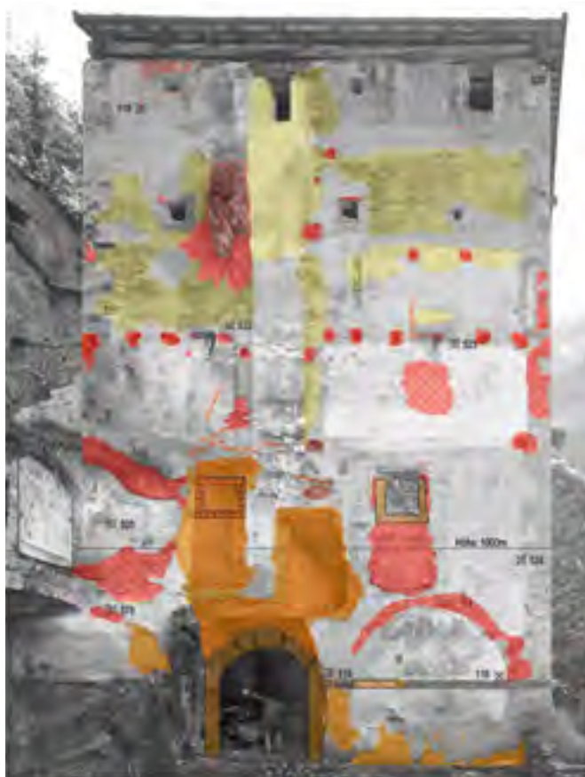
Torturm Fassade NW
