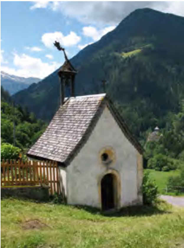
Tobadill, Kapelle in Burgfried, Außenansicht vor Restaurierung, 2008 Foto: Rampold
