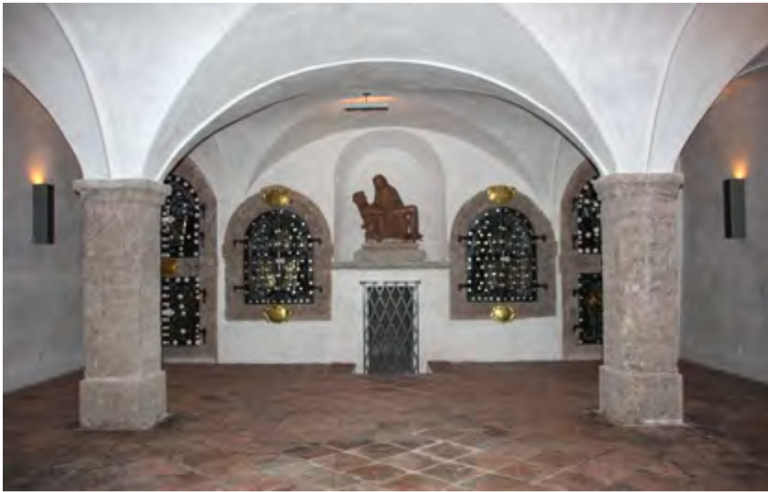
Jesuitenkirche, Jesuitenkrypta nach Restaurierung, 2009 | Foto: Frick
