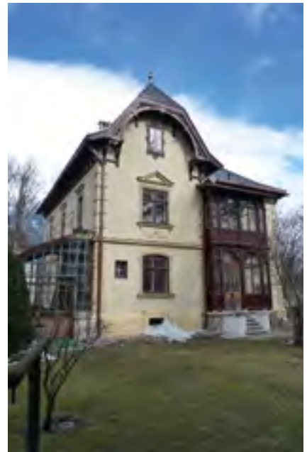
Innsbruck, Siebererstrasse 6, Ansicht von Südwesten, 2010 | Foto: Rehwald
