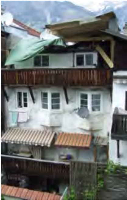
Hall, Agramsgasse 16, eingestellte Baustelle, Ansicht von Süden, 2010 | Foto: Posch
