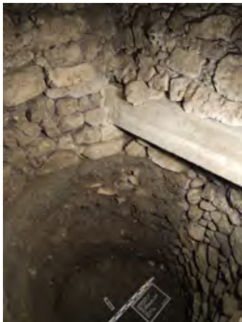
Hall, Altstadtthaus, Gst.Nr. .121, Arbesgasse 13, Grube 2. Rund gemauerter Fäkal-schacht | Foto: Zanesco
