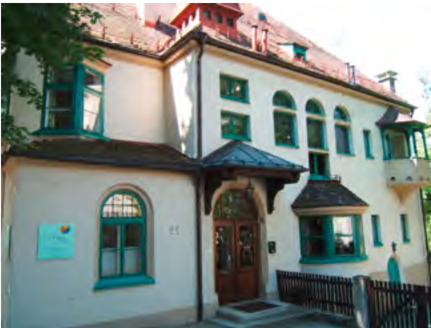
Schwaz, Gilmstraße 2, Riccabona-Villa, Gesamtansicht von Nordosten, 2007 Foto: Tschallener
