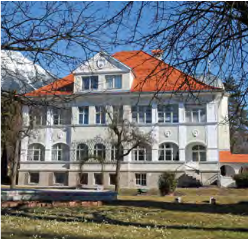
Innsbruck, Richard Wagner-Straße 3, Südwestansicht, 2010 | Foto: Jud
