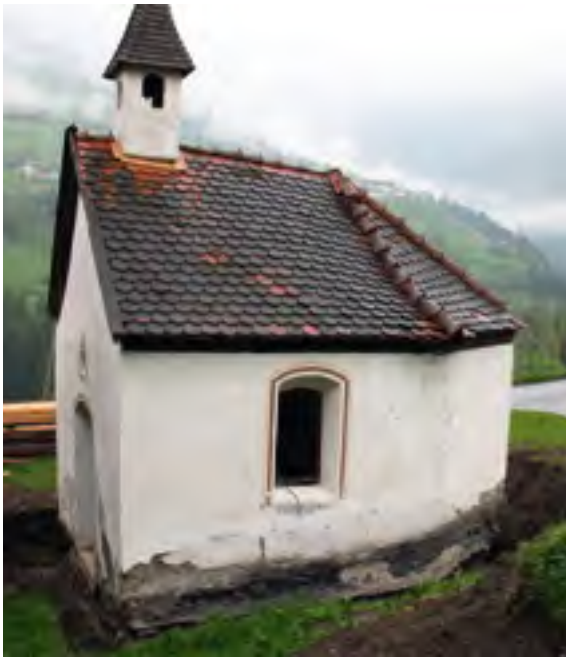
Mühlbachl, Kapelle beim Hogerhof in Matreiwald, Außenansicht während Trockenlegung des Mauerwerks, 2009
