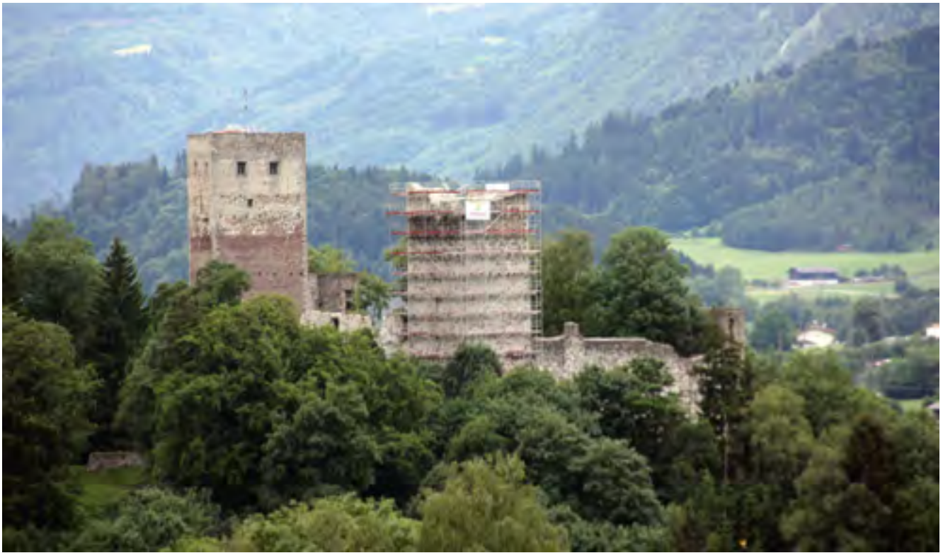
Reith im Alpbachtal, Ruine Kropfsberg, Gesamtansicht der Ruinenanlage von Osten mit den beiden Türmen der inneren Burganlage, 2009 während der Restaurierung | Foto: Hauser
