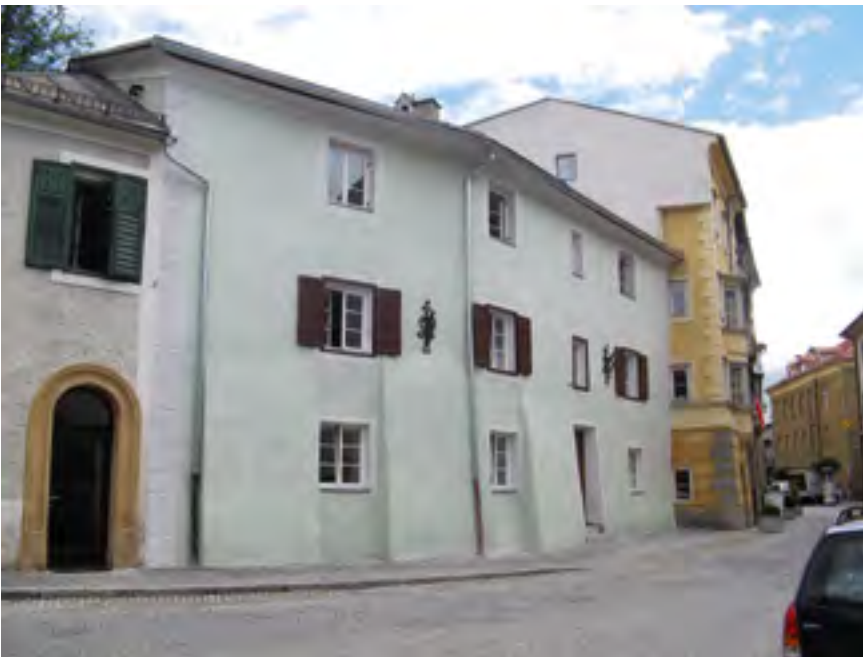
Hall, Krippgasse 26, Ansicht von Süden, 2010 | Foto: Posch
