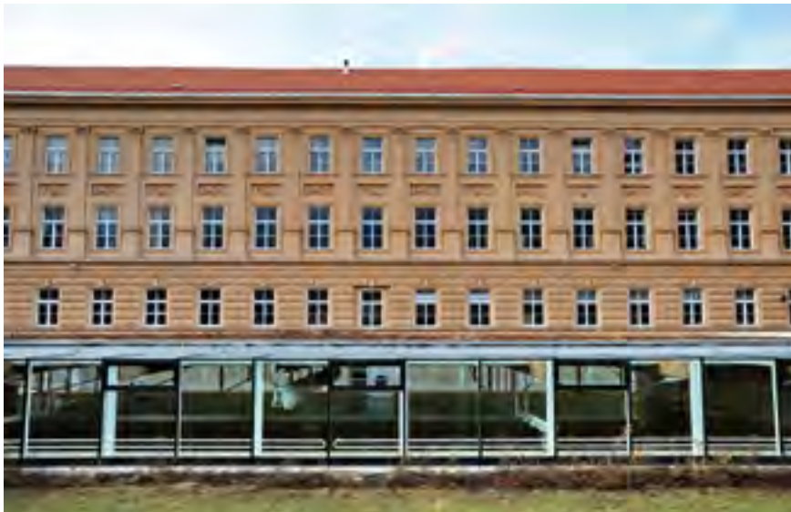
Innsbruck, Siebererstraße 7–9, Siebererschule, Ansicht von Norden | Foto: Jud
