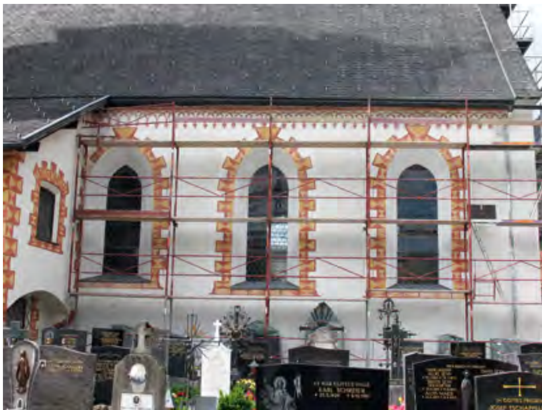
Tösens, Pfarrkirche hl. Laurentius, Südfassade während Restaurierung, 2008 | Foto: Rampold
