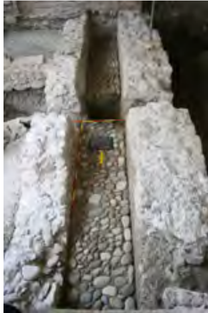
Innsbruck, Mittelalterliche Stadtmauer und Zwinger im ehemaligen Geschäftslokal Leder Lechle, Burggraben 29, Draufsicht auf barocken Abwasserkanal | Foto: Pöll
