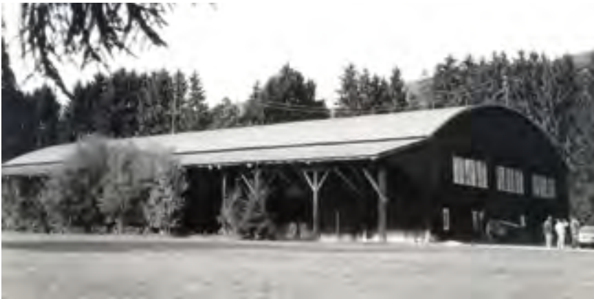
Gesamtansicht gegen Norden, 1991 | Foto: Hauser
