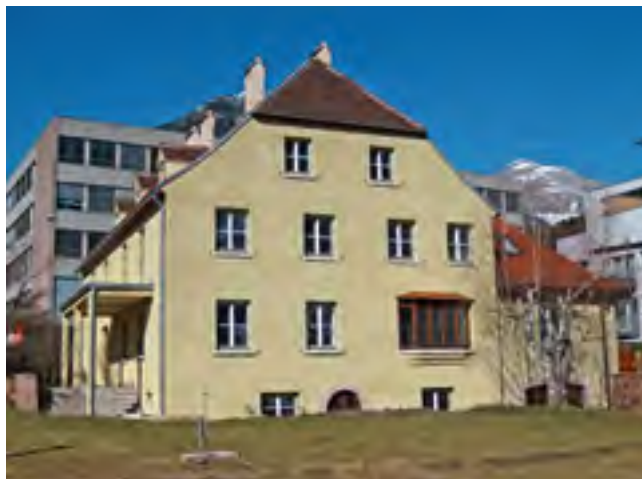
Gesamtansicht gegen Norden nach Restaurierung, 2009 Foto: Hauser
