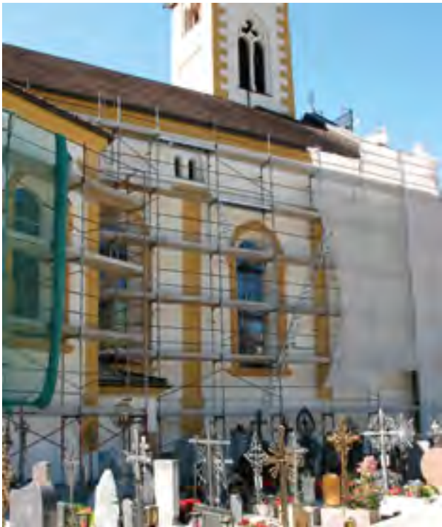
Pfons, Pfarrkirche Mariae Himmelfahrt, Nordfassade während Restaurierung, 2008 | Foto: Rampold
