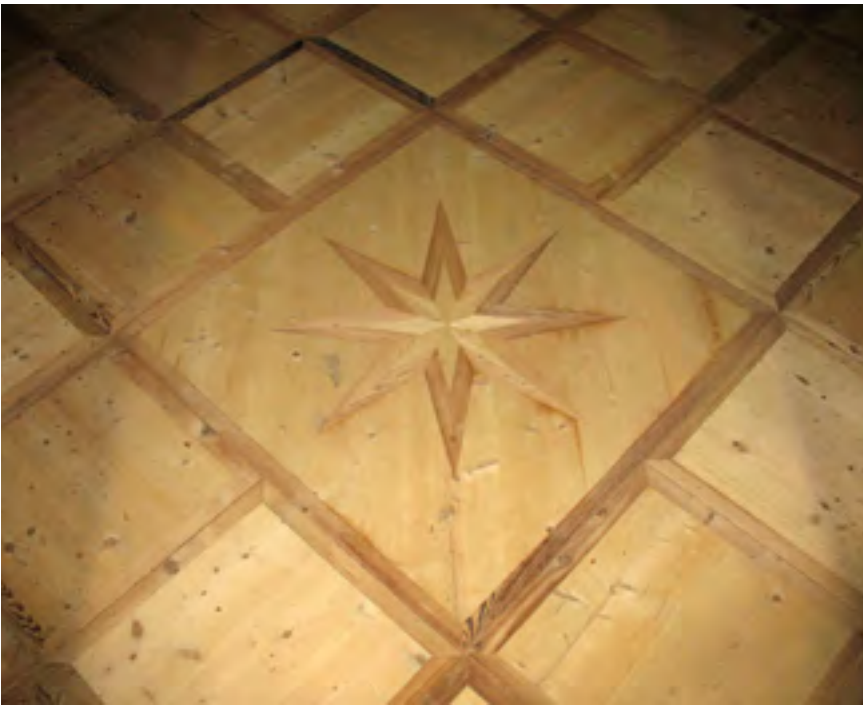
Reith/Seefeld, Pfarrkirche hl. Nikolaus, Boden nach Restaurierung, 2008 | Foto: Rampold
