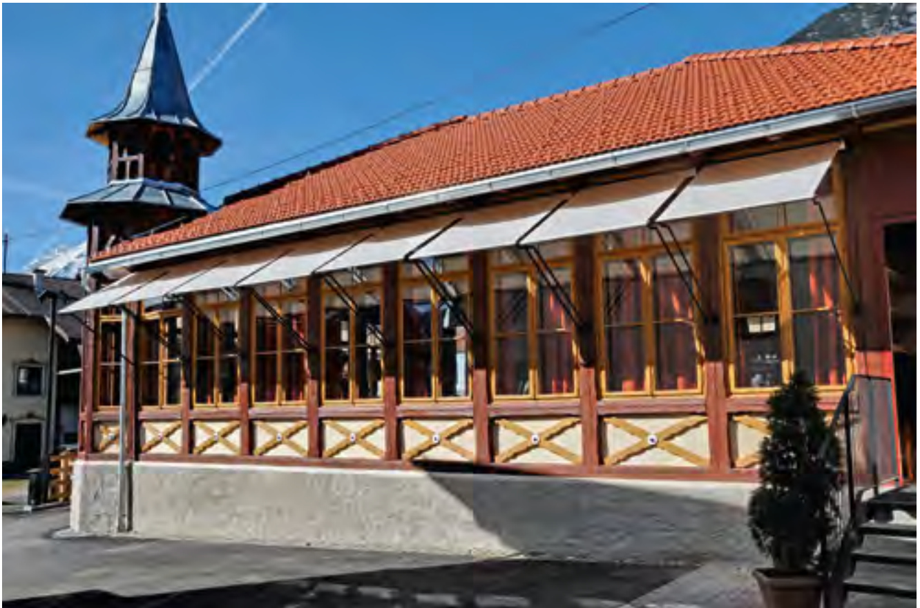
Absam, Walburga-Schindl-Straße 31, ehem. Kirchenwirt, Veranda, Ansicht von Süden, 2010 | Fotos: Jud
