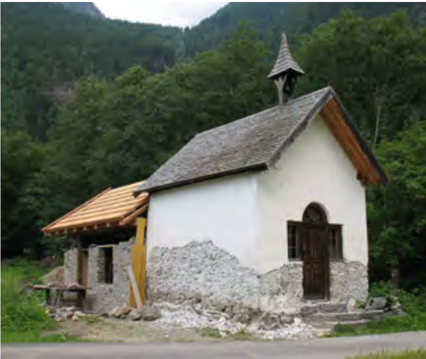
Umhausen, Acherbachkapelle, Außenansicht während Sanierung, 2008 | Foto: Rampold
