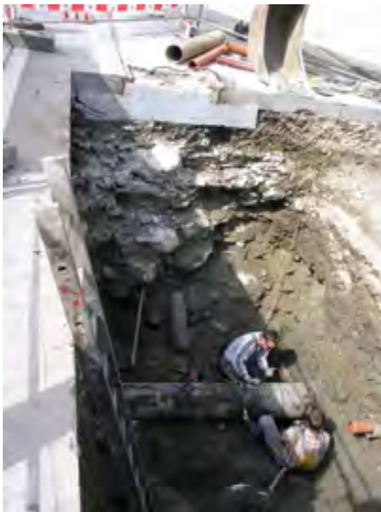
Innsbruck, Maria Theresienstraße und ehem. Vorstadttor, archäologische Baubegleitung, Gst.Nr. 1047, 1050, Rest der Westmauer des mittelalterlichen Vorstadtttores im Westprofil des Schachtes | Foto: Pöll
