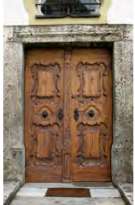
Fieberbrunn, Kirchweg 4, Widumtür nach Restaurierung, 2008 | Foto: Rampold
