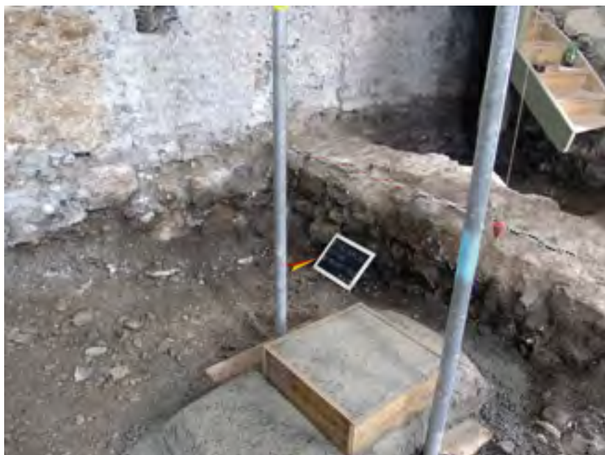
Forchach, Expositurkirche Hl. Sebastian, Bauaufnahme nach Bodenabtrag, Gst.Nr. .12, Blick auf die 1861 abgetragene Süd-mauer der barocken Kirche | Foto: Pöll
