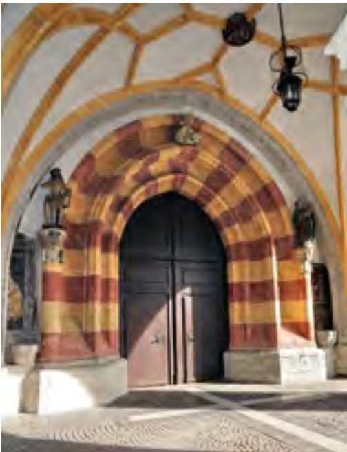
Hall, Pfarrkirche hl. Nikolaus, Vorhalle von Westen, 2010 | Foto: Jud
