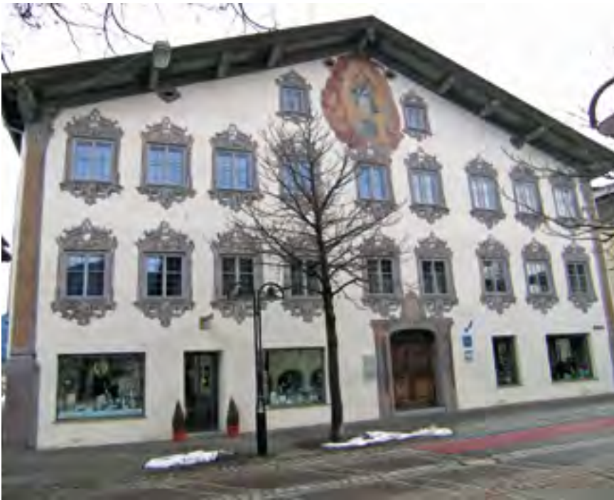
Reutte, Untermarkt 24, Tauscherhaus, Gesamtansicht gegen Osten, 2010 Foto: Stadtwerke Reutte
