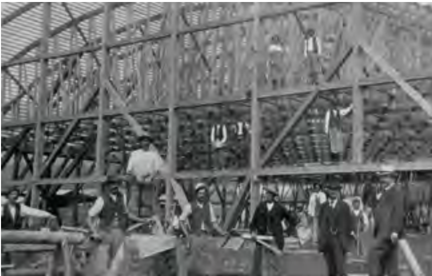
Kirchberg, Brixentalerstraße 17c, Eichenhalle, Historische Abbildung während der Errichtung 1904 | Foto: Archiv BDA
