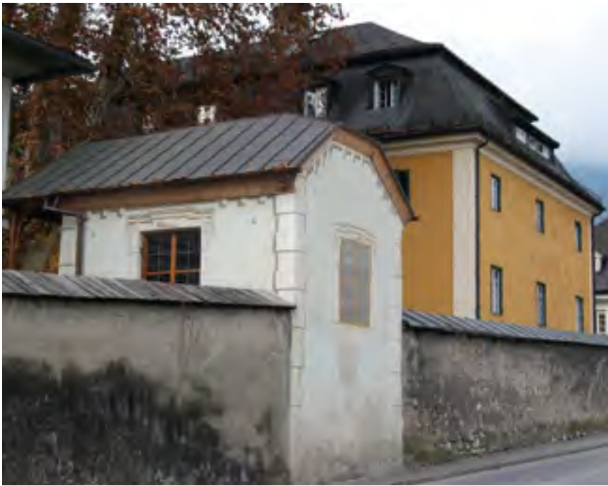
Hall, Bruckergasse, Gartenhäuschen, Gesamtansicht, 2009 | Foto: Neumann
