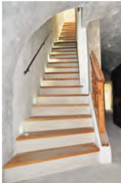
Stiege nach Restaurierung, 2009 | Foto: Jud
