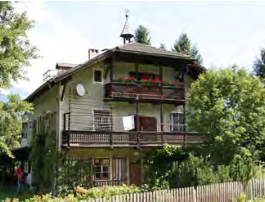
Volders, Schaffervilla, Gesamtansicht, 2008 | Foto: Frick
