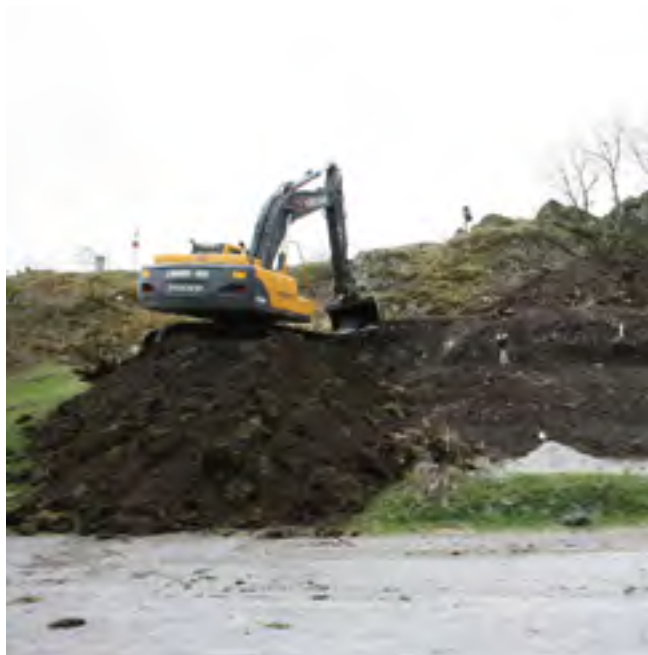
Ladis, Archäologische Baubegleitung beim Rauthhof, Gst.Nr. 1013/3, Grabungsfläche während der Arbeiten | Foto: TALPA
