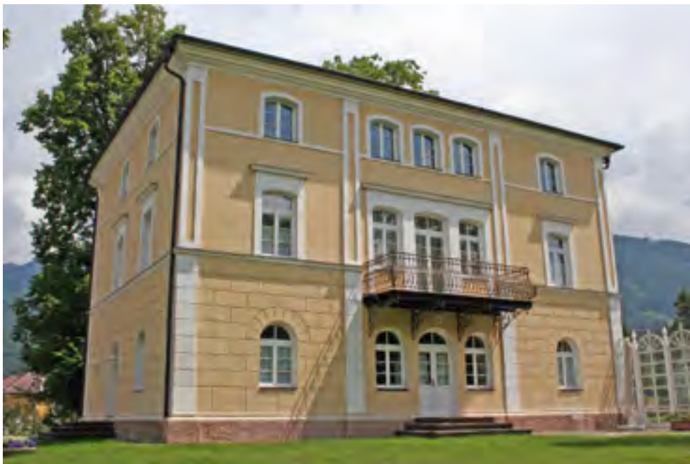
Lans, Kralbergweg 31, Denkmalanlage Ansitz Oellacher, Gesamtansicht, 2008 | Foto: Frick
