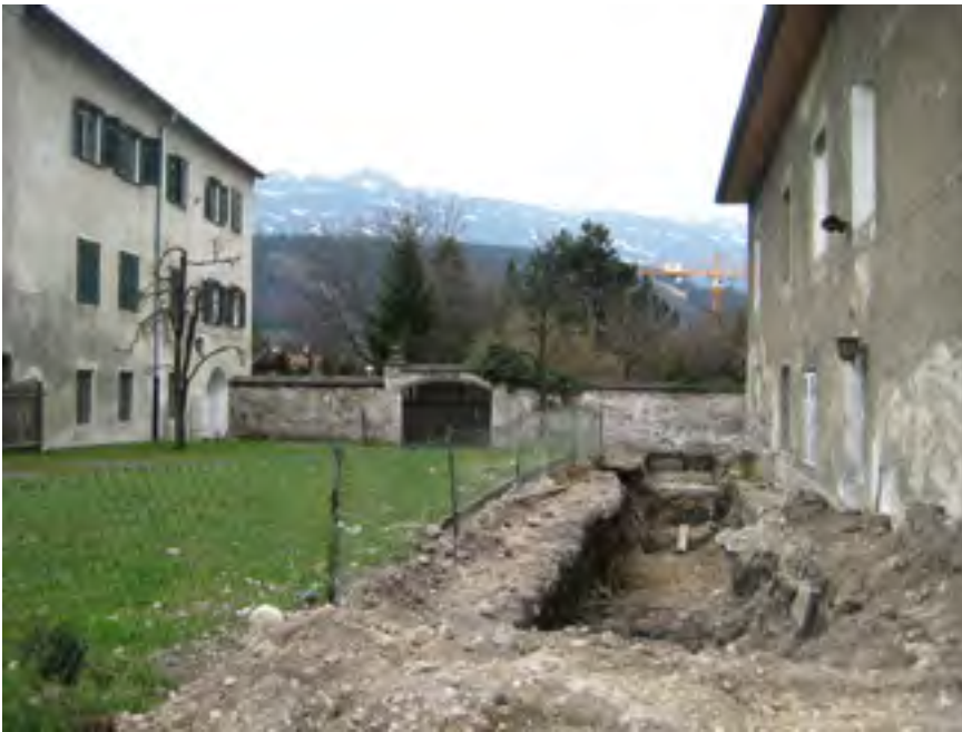
Hall, Ansitz Aicham, GSt.Nr. 238/2 u. 406/1, Sulzgasse 6, Haus Sulzgasse 6 und Bagger-schnitt | Foto: Zanesco
