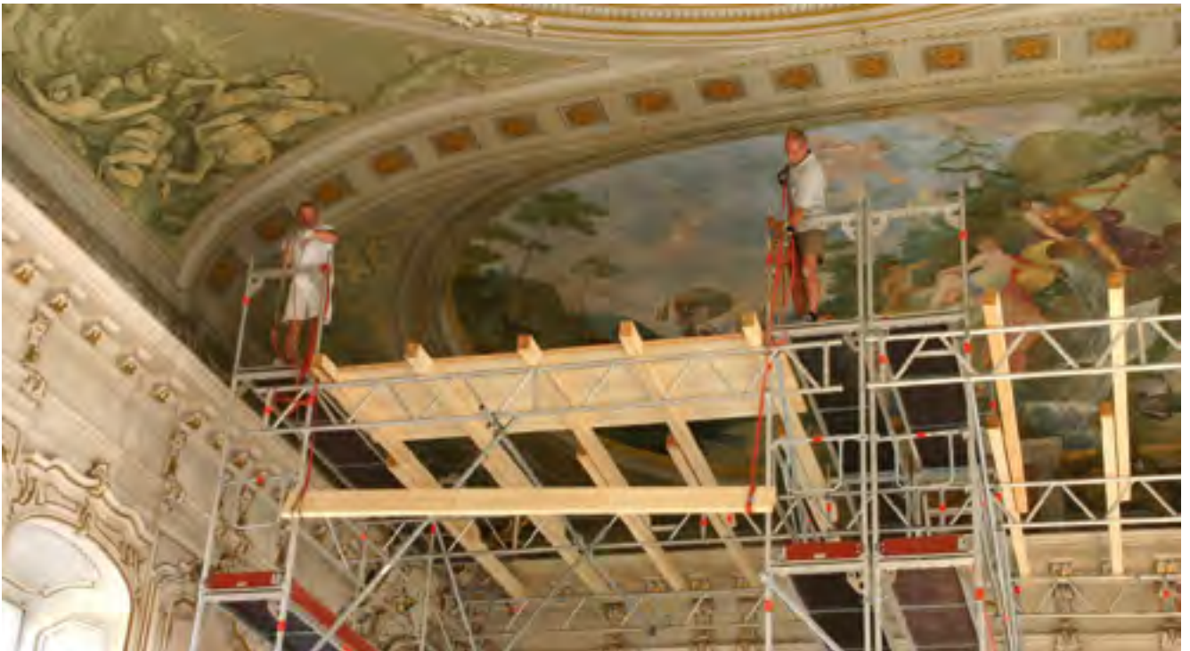
Innsbruck, Rennweg 1, Hofburg, Riesensaal, Arbeitsgerüst
