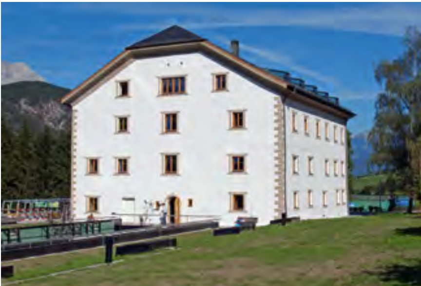
Stams, ehem. Gasthof Speckbacher, Gesamtansicht gegen Nordosten, 2009 | Fotos: Hauser
