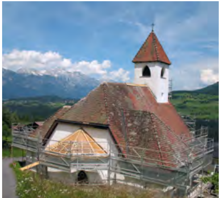
Mutters, Filialkirche Herz Jesu in Kreith, Außenansicht während Sanierung, 2008 | Fotos: Rampold
