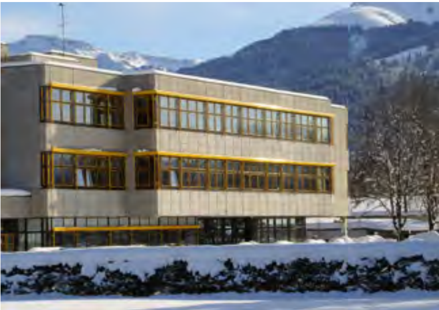
St. Johann i. T., Hauptschule, Gesamtansicht, 2009 nach der Renovierung Foto: Architekten P3, St. Johann
