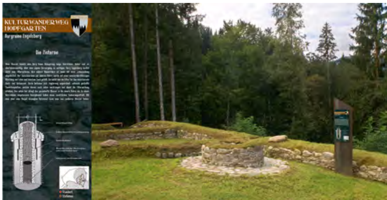
Hopfgarten i. Br., Burgruine Engelsberg, Ruinenteile im Burghof mit Brunnen, 2009 nach der Konservierung Foto: Ehammer/Kinig Hopfadner
