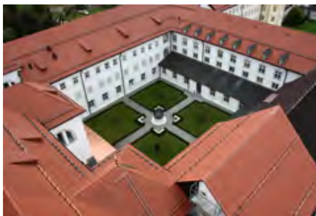
Aufsicht auf die Dachlandschaft mit Kreuzhof, 2009 | Foto: Frick
