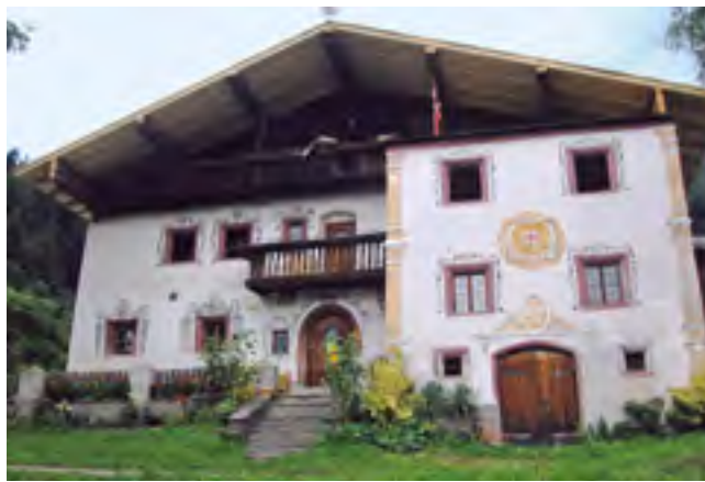
Kirchbichl, Oberluech – Larchhof, Fassadenansicht
