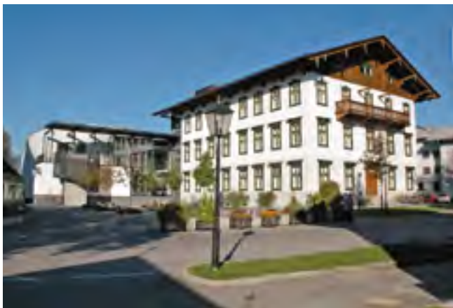
St. Johann in Tirol, Adaptierung des alten Schulhauses
