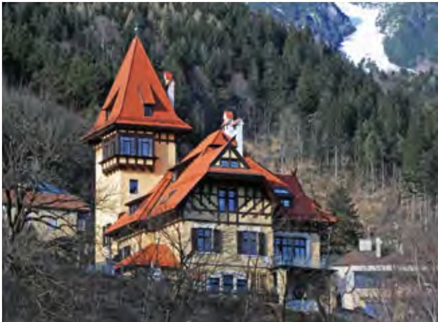
Innsbruck, Richardsweg 7, Ansicht von Südwesten, 2010 | Foto: Jud
