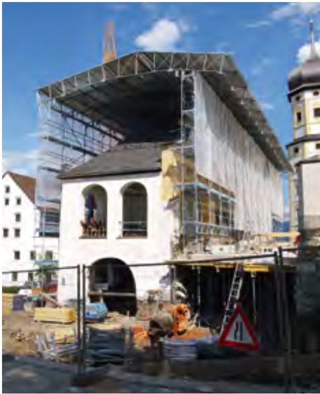
Stams, Orangerie mit Schuttdachkonstruktion, 2009 | Foto: Frick
