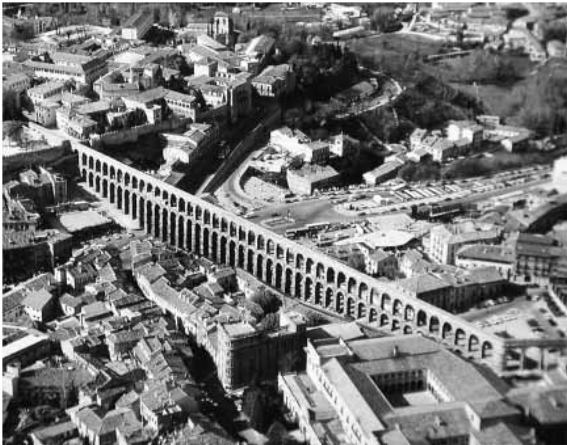
Der Aquädukt in Segovia: Trotz der Mächtigkeit und der großen Abmessungen ist dieses Bauwerk in Verbindung mit dem gewachsenen Gebäudeensemble als Ganzes ein wunderbares Baukulturgut.
