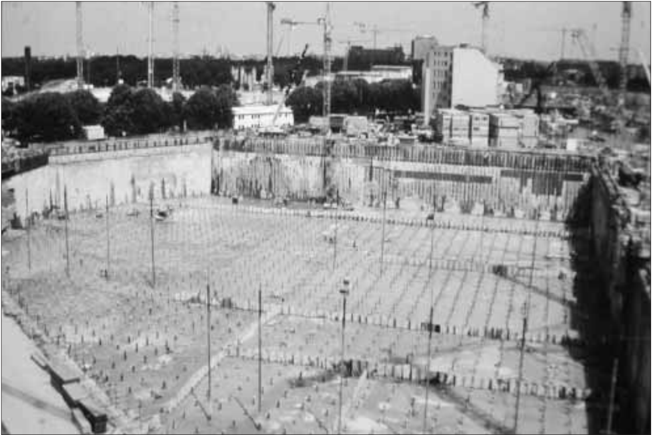
Blick in die trockene Baugrube
