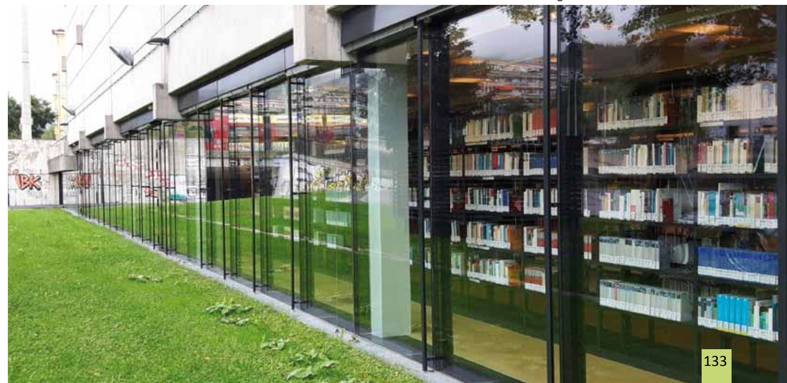
Ansicht auf den 2009 in Betrieb genommenen Neubau © Silvia Kössler
