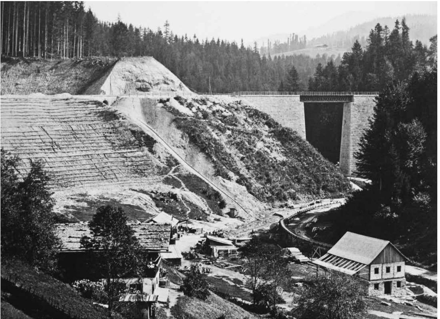
Stahlbetongewölbes eine Brücke als Strebenfachwerk mit oben liegender offener Fahrbahn gebaut. Herausragende Ingenieurskunst zu einer Zeit, als noch ein einziges Gleis dem geringen Zugsverkehr genügte. Wegen der großen Spannweite von rund 60 Meter wurden zwei Tragwerke erforderlich, die einerseits auf dem Hauptpfeiler, andererseits auf den beiden Widerlagern ruhen. Besonders markant wirkte der 25 Meter hohe Hauptpfeiler.
