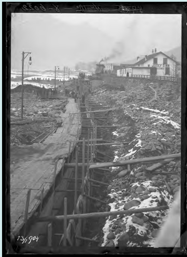
Bau der Wassermauer in Bozen, im Hintergrund ein Gebäude mit der Aufschrift „Josef Sinn Fassbinder“, 1904
