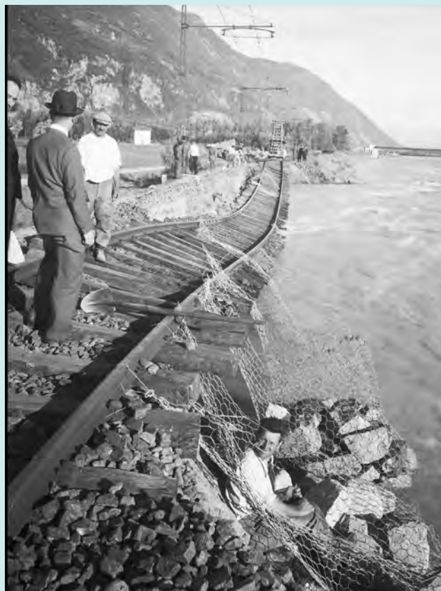
Hochwasser am Fluss Etsch, vom Wasser unterspülte Gleise, 1940
