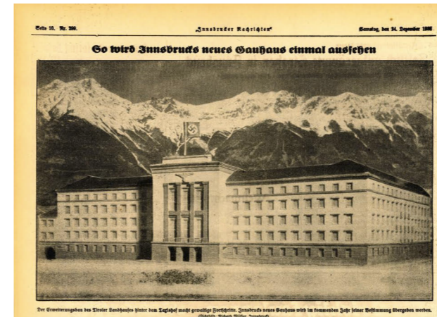
Zeitgenössischer Bericht zum Baufortschritt der Landhauserweiterung
