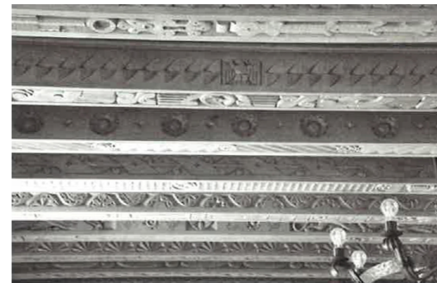
Balken im Hofer Zimmer
