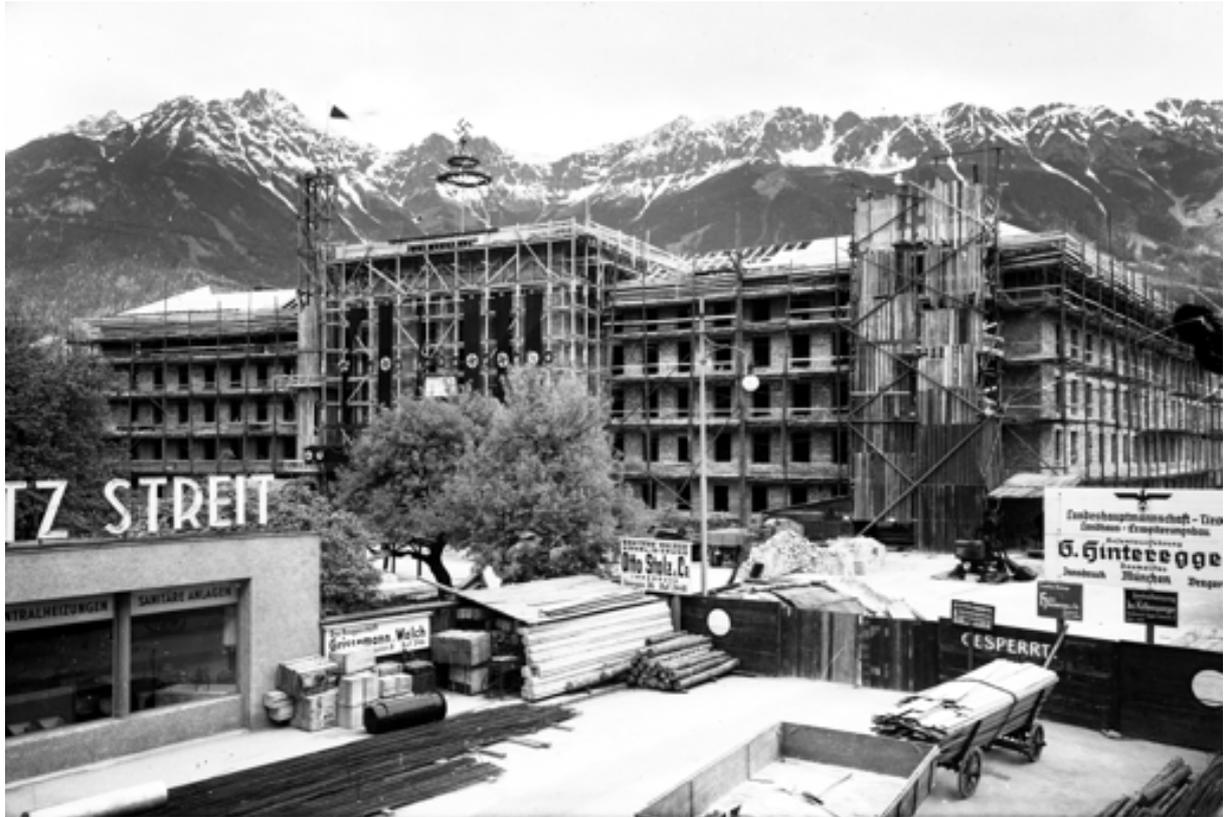
Abb. 32, Baustelle Erweiterungsbau mit Holzgerüsten, Materialaufzug und Fahnenstange für die Firstfeier, Mai 1939, Foto: Richard Müller (StAI, NL Richard Müller).
