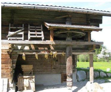
Das zweigeschossige Gebäude besteht aus einem überkämmt Kantholzblockbau, das allseitig vorkragende Satteldach ist in Pfettenkonstruktion gestaltet, das Dach wurde im Zuge der Übertragung saniert.
