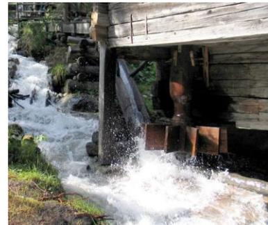
Ihre Errichtung war kostengünstig, das Funktionsprinzip ist einfach, der Betrieb kaum störungsanfällig. Die Bauern konnten derartige Mühlen selbst errichten, betreiben und damit den Eigenbedarf an Mehl decken.
