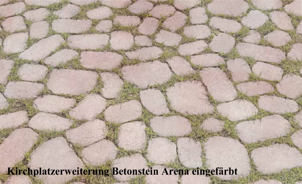
Kirchplatzzerweiterung Betonstein Arena eingefärbt
