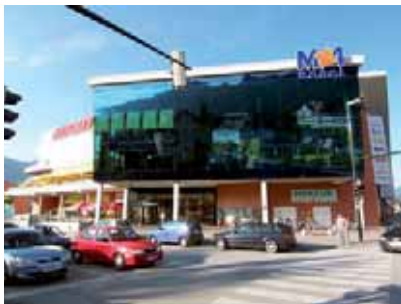
Das EKZ „M4“ in Wörgl liegt an der Hauptverkehrsachse und besitzt attraktive Magnetbetriebe 1
