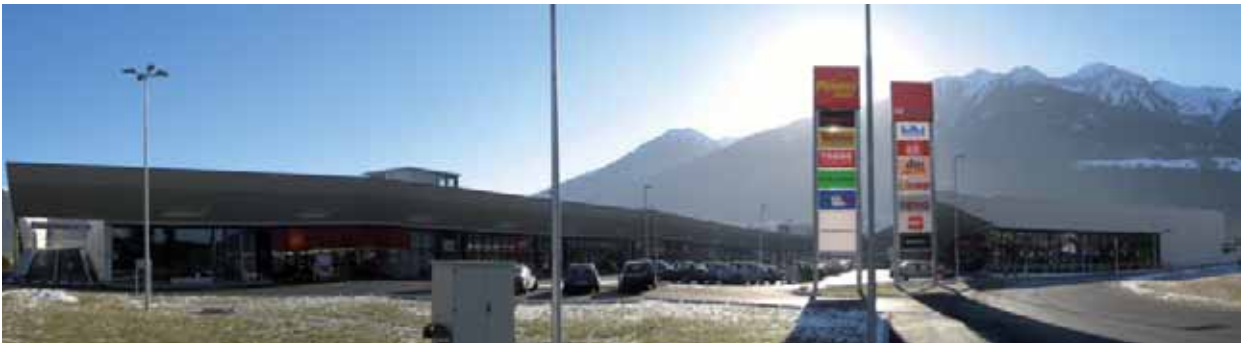
Im Jahr 2008 wurde das modern und innovativ gestaltete FMZ Telfs Süd eröffnet. Die Parkierung erfolgt u.a. auf der Dachgeschossebene des Centers
