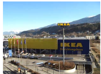
Das IKEA Möbel- und Einrichtungshaus liegt als weiterer Magnetbetrieb direkt benachbart zum DEZ
