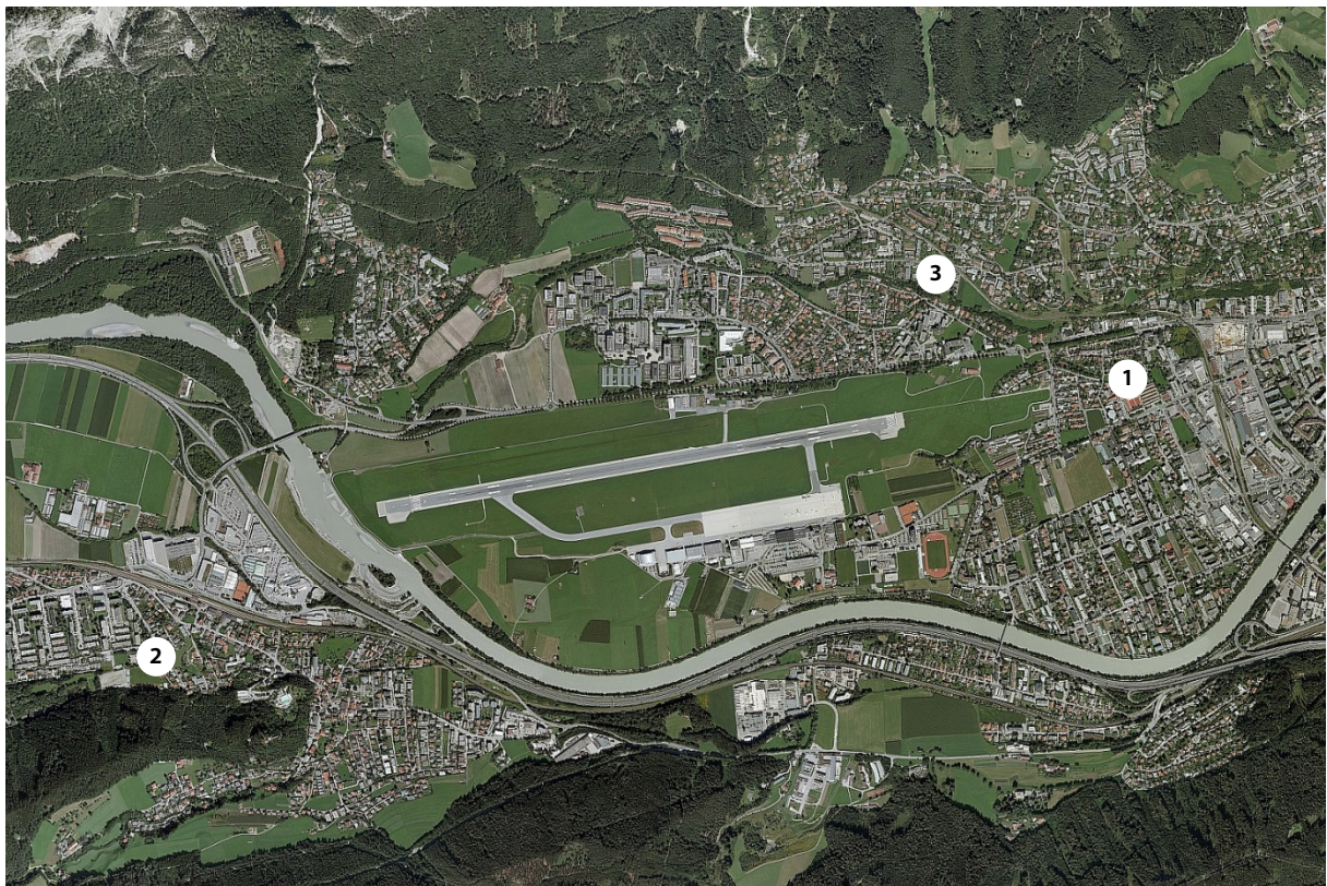
Abbildung 1: Flughafen Innsbruck mit Messstellen
