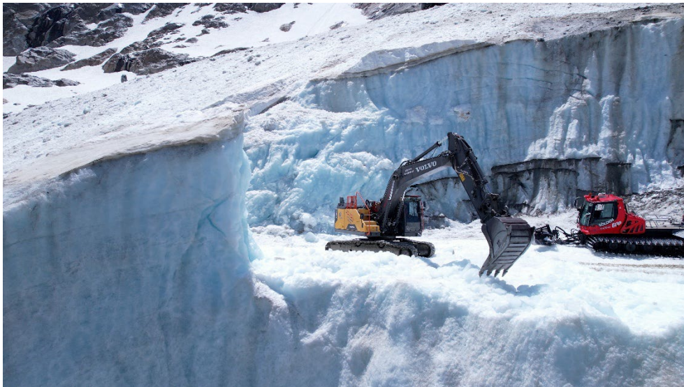
Bagger am Gletscher
