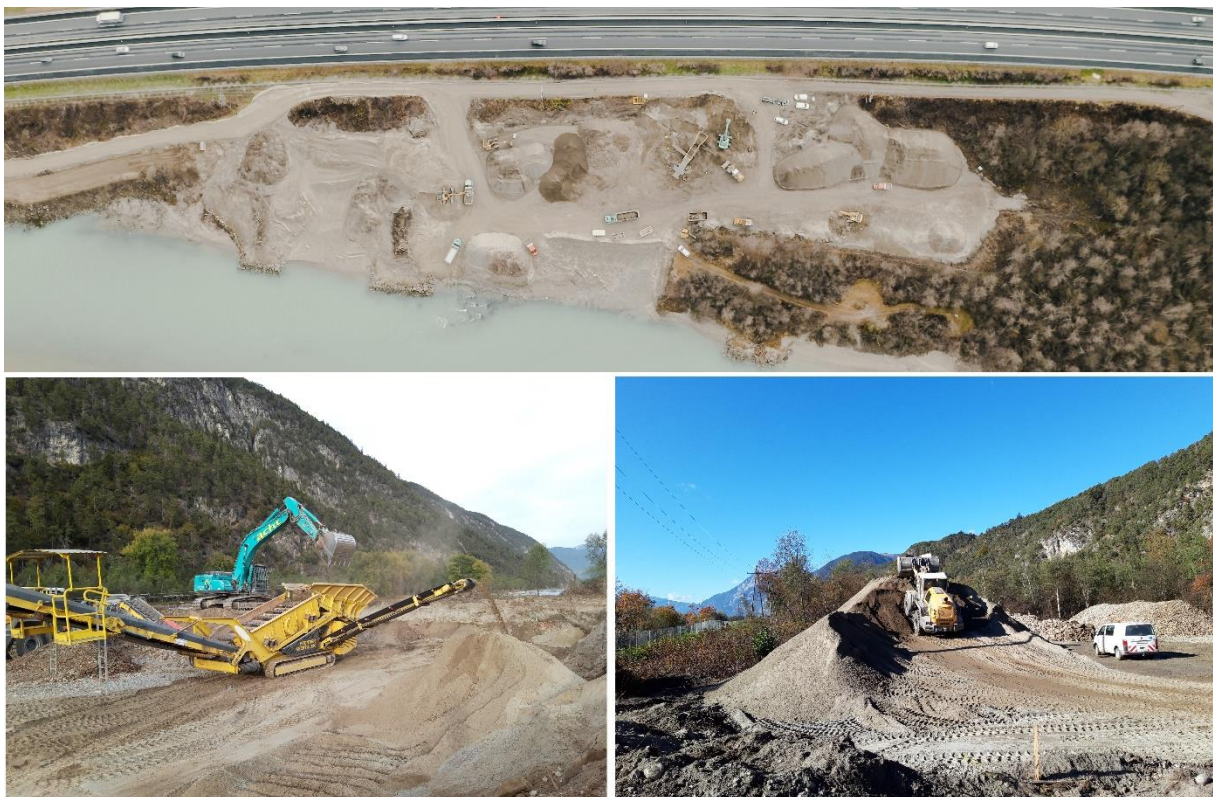
Abb. 4: Aushubarbeiten Verdachtsfläche 1, oben: Überblick Baustellenfläche, links: Beschickung der Siebanlage, rechts: Zwischenlagerung der gesiebten Fraktionen zu Haufwerken
