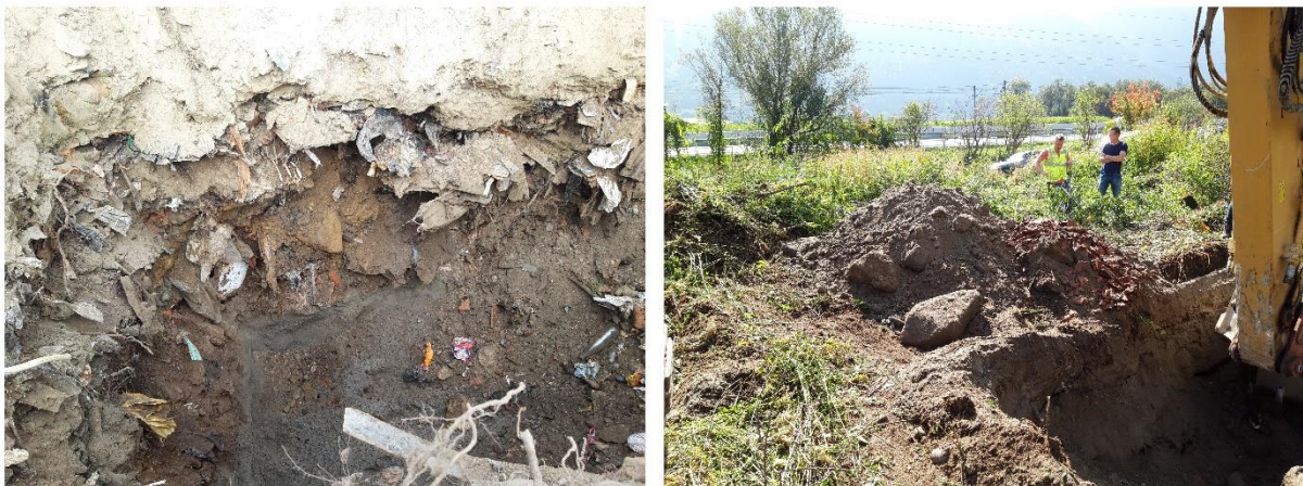
Abb. 2: Probeschlitze bei der Erkundung der Altablagerungen, links: „Hausmüll“, rechts: „Baurestmassen“ (28.September.2021)
