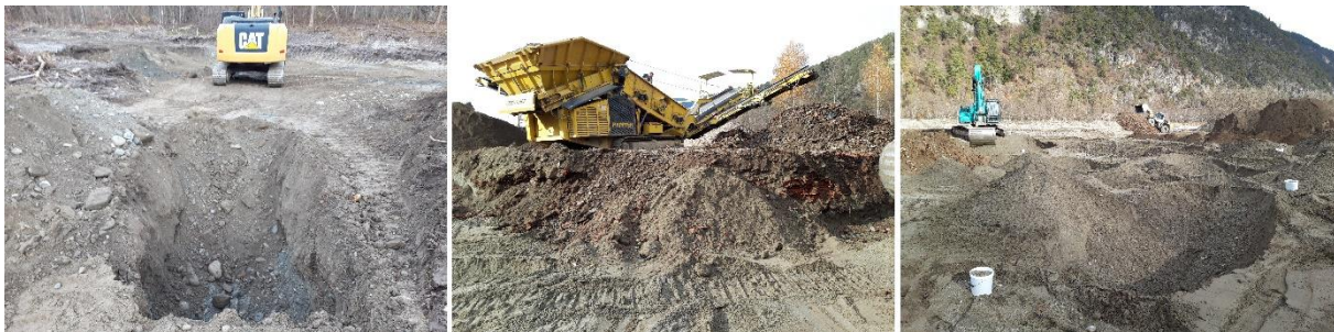
Abb. 6: Untergrunderkundungen: links: Beprobung der Verdachtsfläche 1, mitte: Schichtprofil der Ablagerung auf Verdachtsfläche 2, darunter natürlich gewachsener Boden (Ausand), links: Beprobung des Untergrunds nach Aushub auf Verdachtsfläche 2
