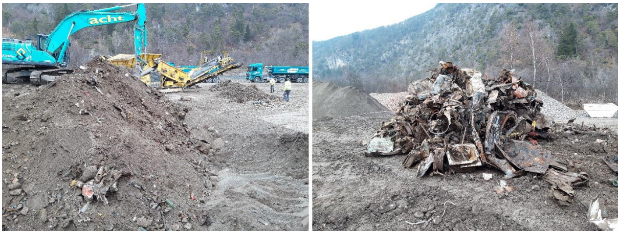
Abb. 7: Aushub des Bereichs Hausmüll, links: deutlich mehr Störstoffe im Aushub und händische Nachsortierung an der Siebanlage, rechts: mit Bagger aussortierte große Metallteile.
