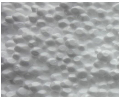
Abbildung 3: Bruchfläche einer EPS-Dämmplatte, Bild: Clemens Demacsek (GPH)
