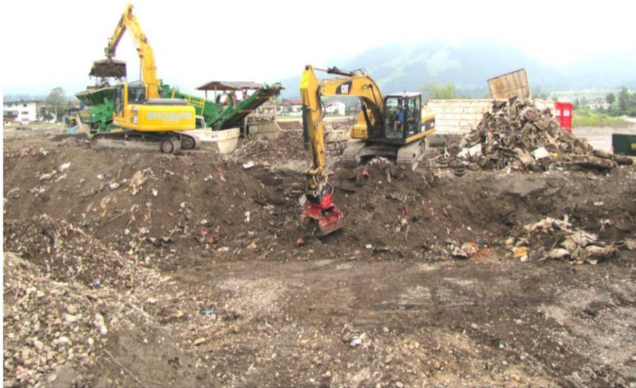
Die im Mittel etwa 15 cm starke „Schlick“- bzw. Detritus-Schicht wurde zwecks Lagerung beprobten Materials (und dem dafür erforderlichem befahrbaren Untergrund) abgeschoben und nach entsprechender Be-
