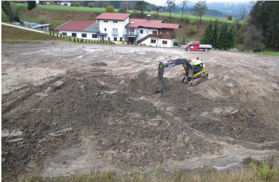
Abb. 9: Deponie Ritzer: Verräumen und Einbau aus der Auwirtslacke angelieferter strukturarmer, nasser Chargen (24. Oktober 2014)
