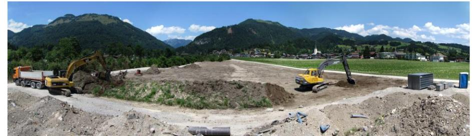
Abb. 4: Verladen des abgeschobenen Oberbodens vermischt mit Mähgut, rechts: angelieferter Bauzaun und Toilette (7. Juli 2014)
