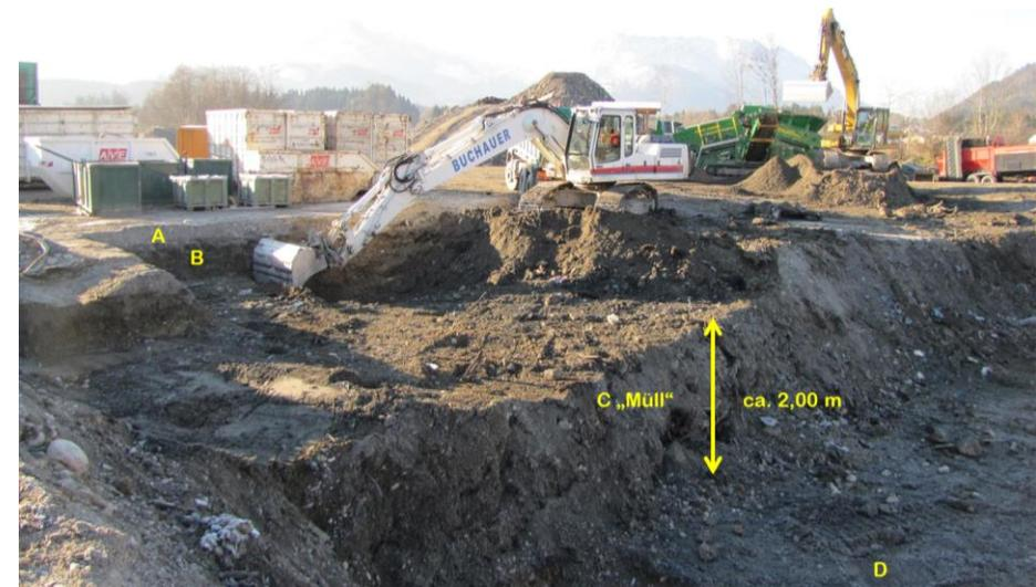
Abb. 12: Abtragen eines typischen vertikalen Schichtprofils A Schotter B unbelasteter Aushub C „Müll“ D Detritus (9. Dezember 2014)
