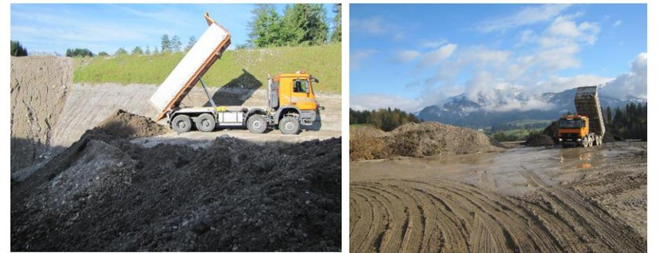
Abb. 43: Abladen von Bodenaushub der Qualität „Bodenaushub mit Hintergrundbelastung“ auf der Deponie Ritzer (links) bzw. der Qualität „Inertabfall“ auf der Deponie Hallbruck (rechts)
