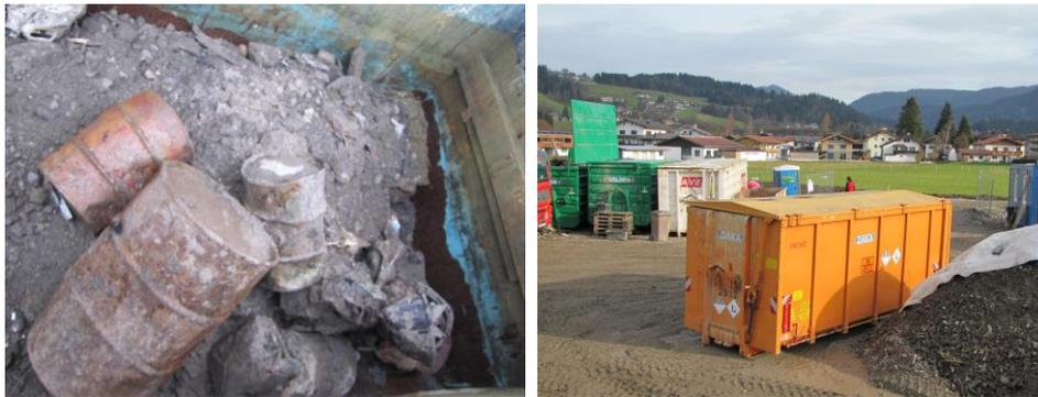
Abb. 40: Ölverunreinigtes Aushubmaterial mit teilweise gefüllten Fässern (links) gelagert in flüssigkeitsdichtem Container (rechts)
