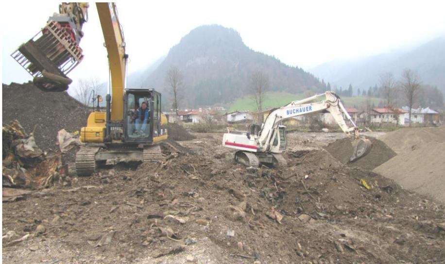
Abb. 15: Aussortieren von Grobteilen: Oben Schrott (Haufen rechts),
