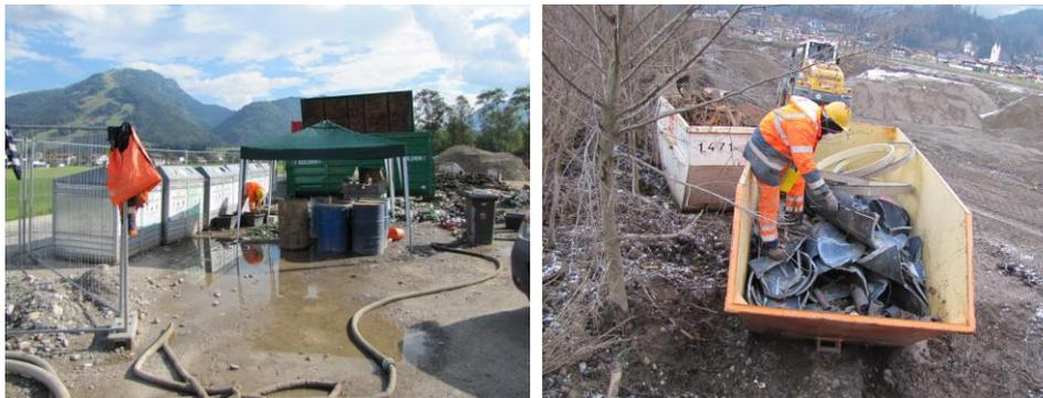
Abb. 41: Überdachte Sammelstelle für Sonderabfall-Kleinmengen (links), Stabilisierung von Asbestabfall vor der Abholung (rechts)
