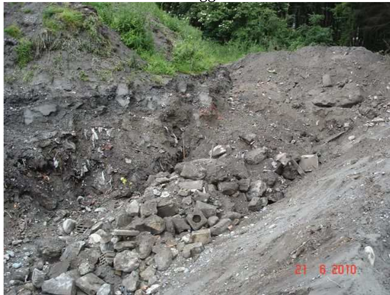
Grube Ost-Bereich – mit Bagger aussortierter Bauschutt
