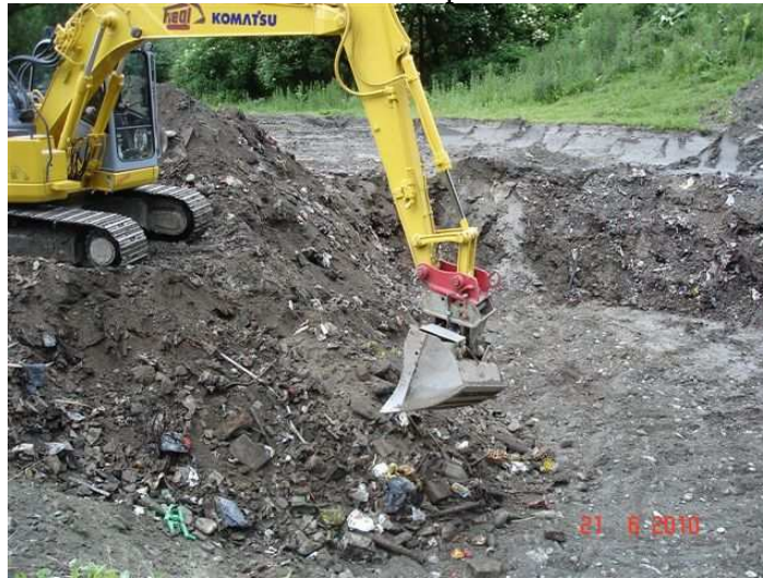
Aushub zentraler Deponiebereich
