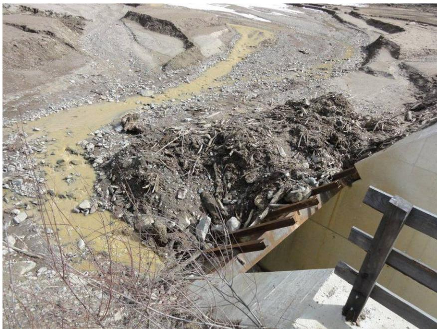
Abbildung 4: Murholz im Geschieberückhaltebecken, Bereich Rechen
