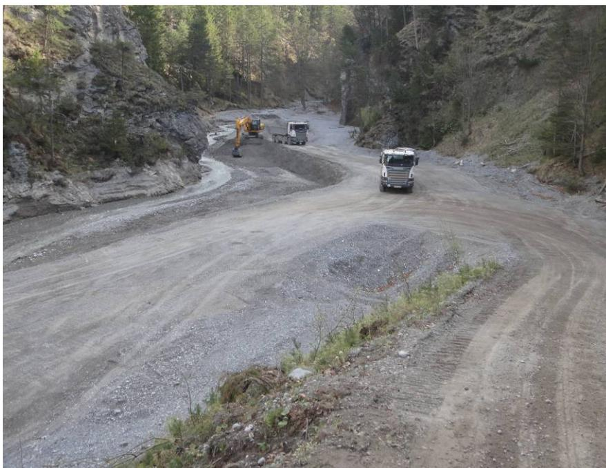
*Abbildung 2: Mechanische Räumung mittels Bagger*
