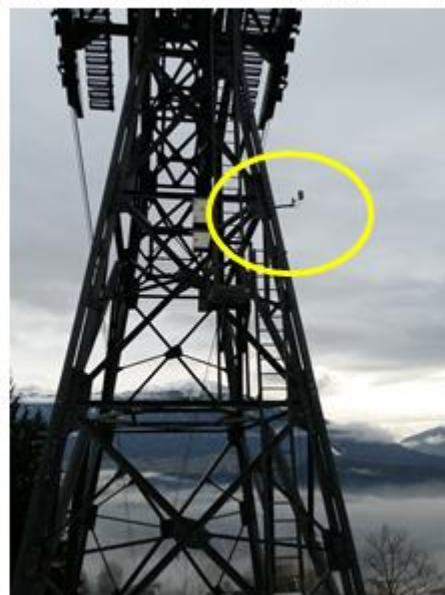
Abbildung A4: TEMPIS-Station Hungerburg (HBG) auf der Hangverflachung des namengebenden Stadtteils (oben, GoogleMaps, auf dem rot strichlierten Trassenverlauf der Nordkettenbahn mit rotem Marker). Die Sensoren für Temperatur- und Feuchte sind auf der 1. Stütze der Nordkettenbahn (unten links, 3D-GoogleMaps, gelb markiert) in 11,5 m über Grund montiert (unten rechts, gelb eingekreist).
