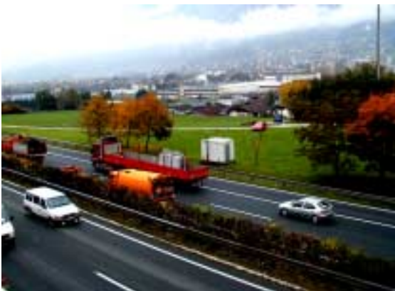
Messstation bei Vomp an der A12 (Bildmitte)
