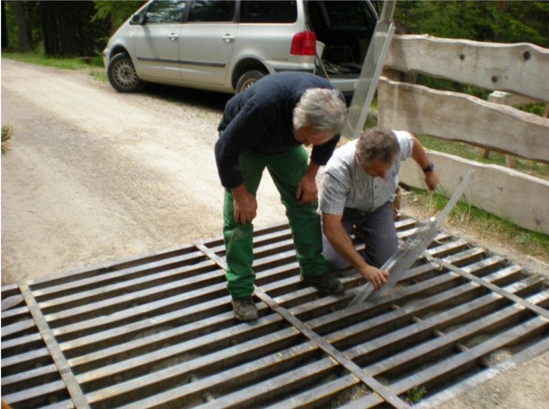
Abb. 12: Einbringung der gesamten Konstruktion durch die Abstände zwischen den Eisenträgern
