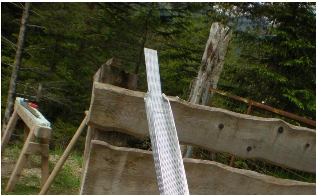
Abb. 11: Hauptausstiegselement mit vormontiertem Lochblechstreifen
