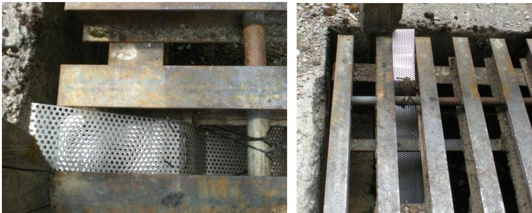
Abb. 15: Montage des eigentlichen Ausstiegsbereiches mittels kurzen Schrauben und Kabel (links) und fertige Ausstiegshilfe mit Erdkröte am Ausgang (rechts)
