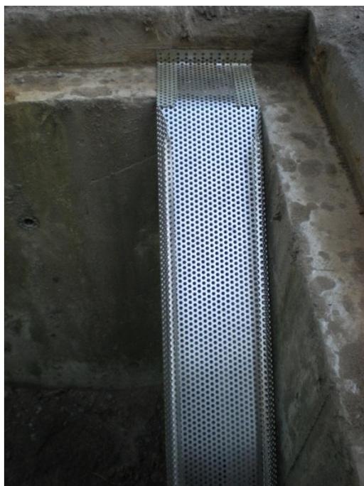
Abb. 7: Auflage der Leiter am Betonabsatz
