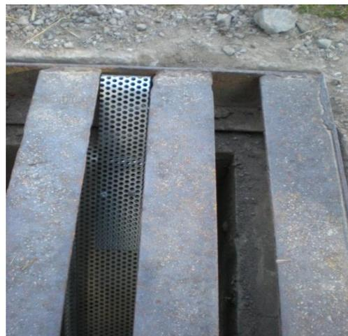
Abb. 9: Verbindung des eigentlichen Ausstiegselementes mit dem Hauptelement
