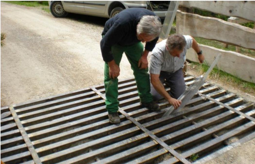
Abb. 5: Seitliches Einfädeln der Ausstiegsleiter in einen Weiderostschacht
