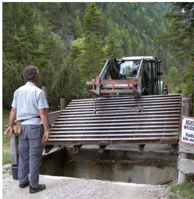
Abb. 3. Entfernung mittels einfacher Hydraulik    Abb. 4 Entfernung der Rostauflage mittels Frontlader
