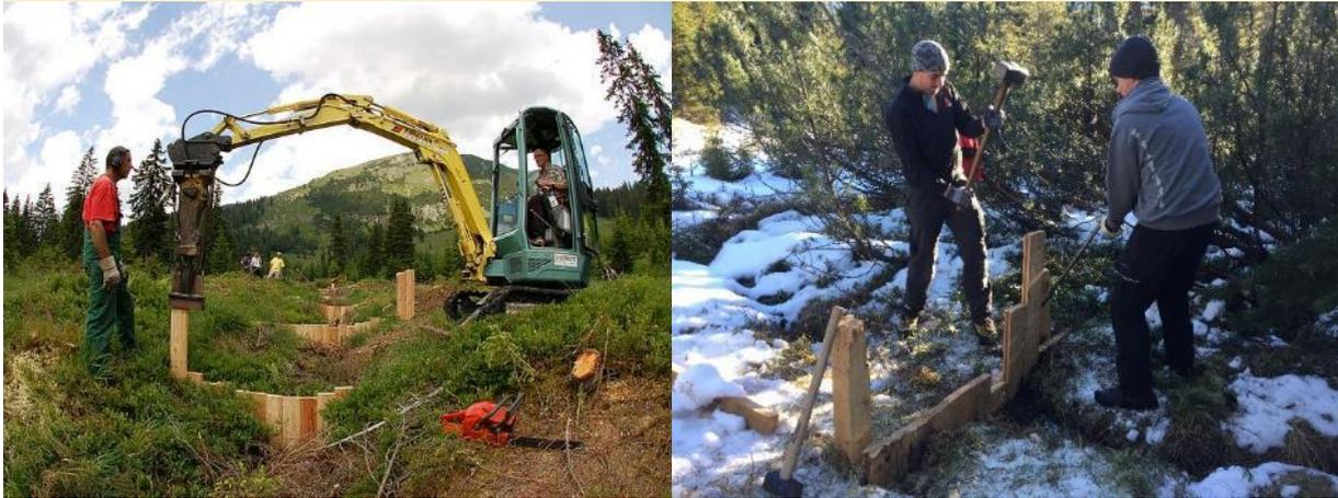
Abbildung 3: Das Setzen der Holzspundwände kann mit einem kleinen Bagger (<3,5 t), oder händisch erfolgen
