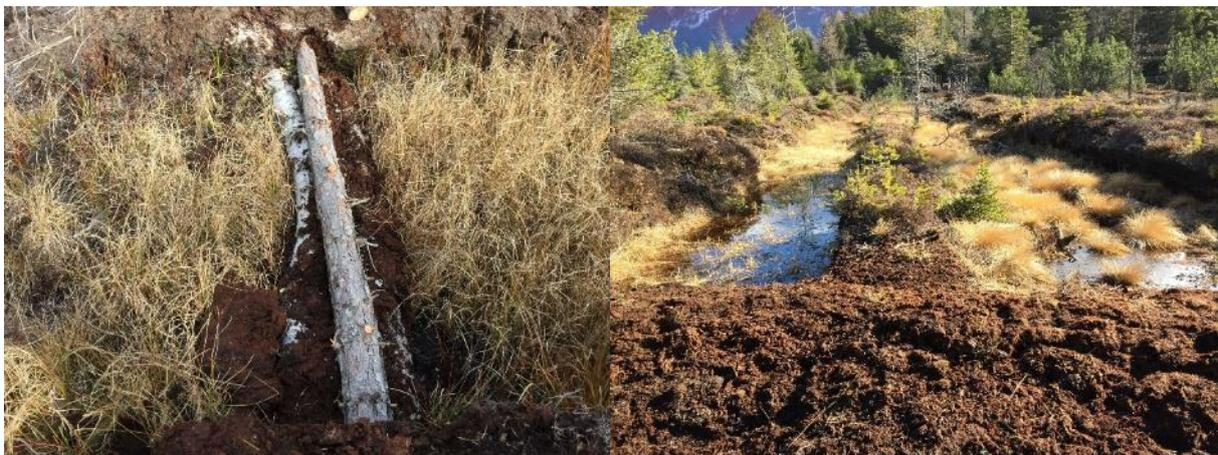
Abbildung 12: Bau der Torfsoden in den Seitengräben des Torfstiches. Links: Ablängen von Baumstämmen für den Kern des Dammes und auffüllen der Hohlräume mit Torf und Torfziegeln aus angrenzenden degradierten Bereichen. Rechts: Querriegel aus Torfsoden an Seitengraben mit Mittelrippe
