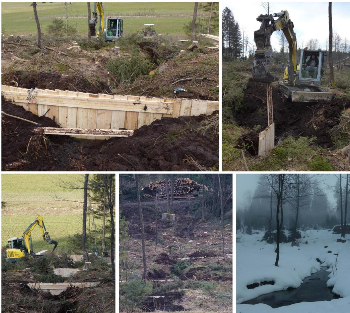
Abbildung 8: Einbauarbeiten der Holzspundwände im November 2021; Bereits gefüllter Wassergraben im Dezember 2021
