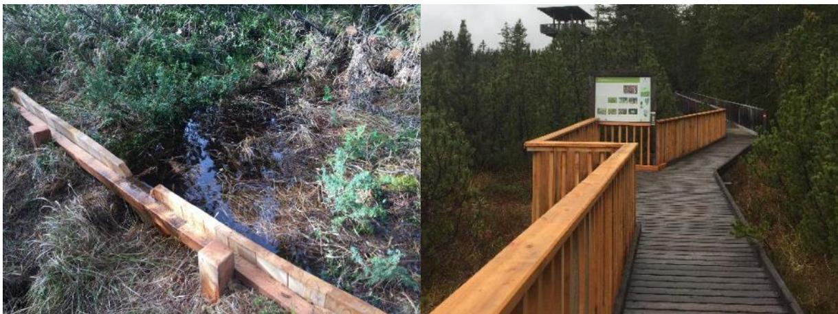
Abbildung 11: Links: eine 2022 gesetzte Holzspundwand. Rechts: das neue Geländer im Bereich des Moorturms soll zukünftig die starke Trittbelastung im Moor verhindern
