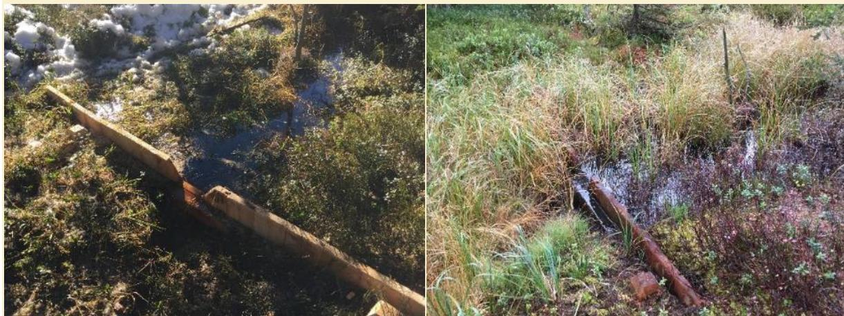
Abbildung 4: Spundwand im Piller Moor kurz nach dem Setzen (links) und nach einem Jahr (rechts)
